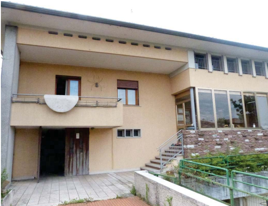
4 Ingresso garage e ingresso principale..
