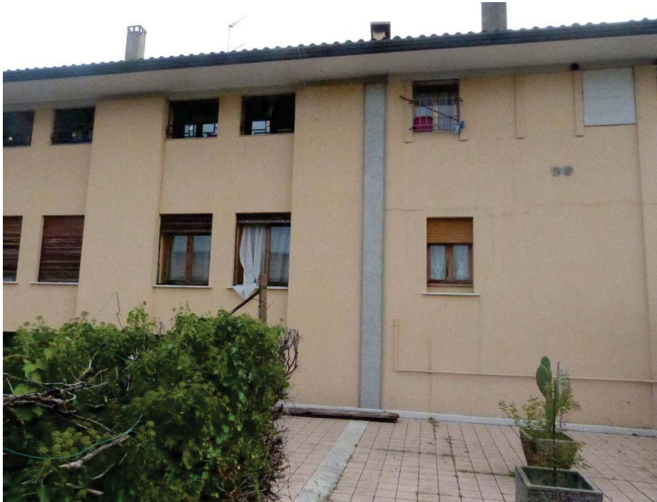
5 Prospetto ovest dell'immobile.
