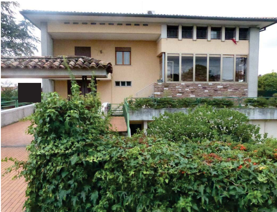
2 Prospetto principale dell'immobile.
