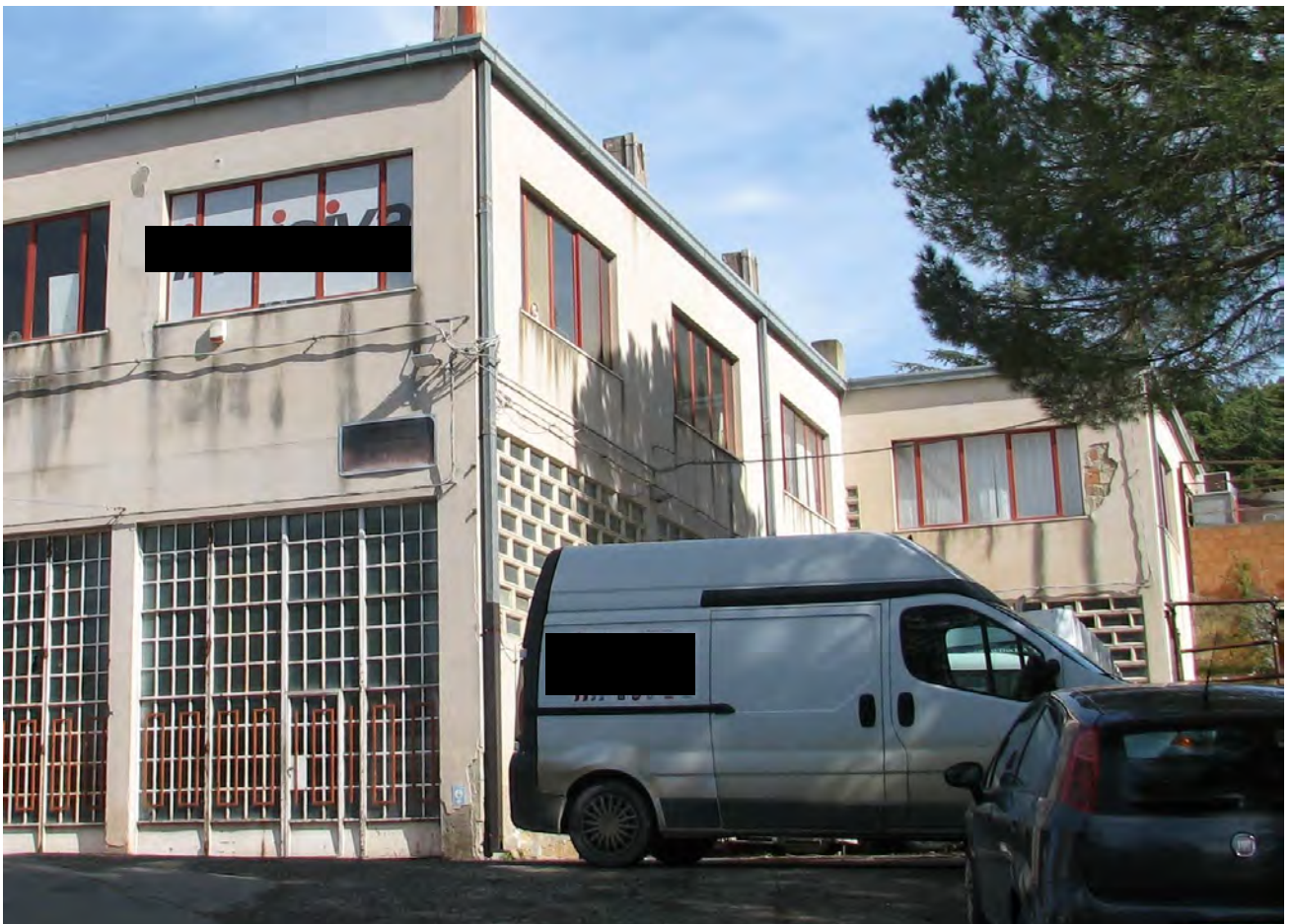
Foto 5 – Prospetto laterale dell’edificio (lato sud)
