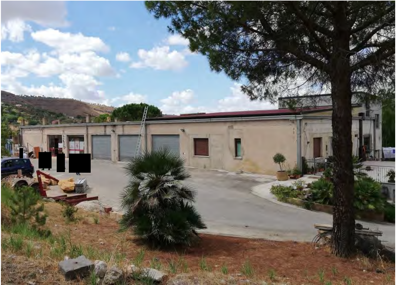
Foto 3 – Prospetto retrostante dell'edificio (lato est)
