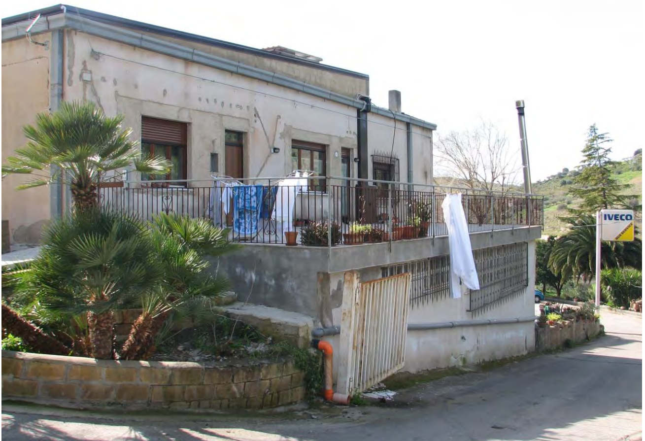
Foto 4 – Prospetto laterale dell'edificio (lato nord)
