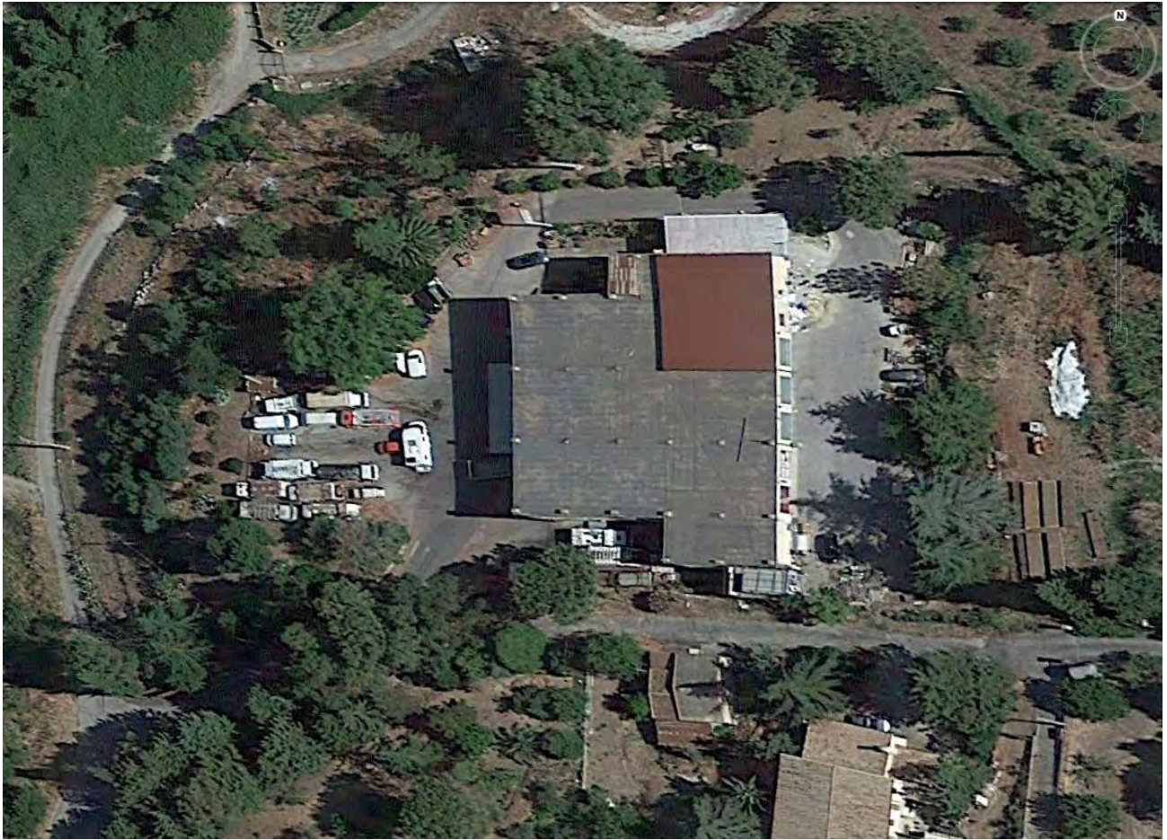
Foto 1 – foto aerea e copertura (prevalentemente piana) del fabbricato
