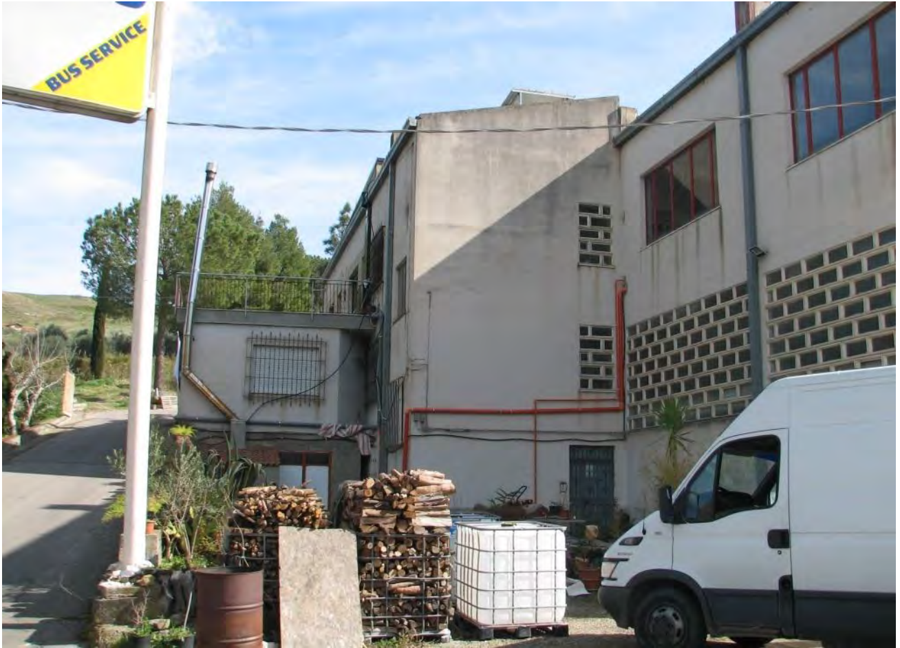
Foto 6 – Prospetto laterale dell’edificio (lato nord)
