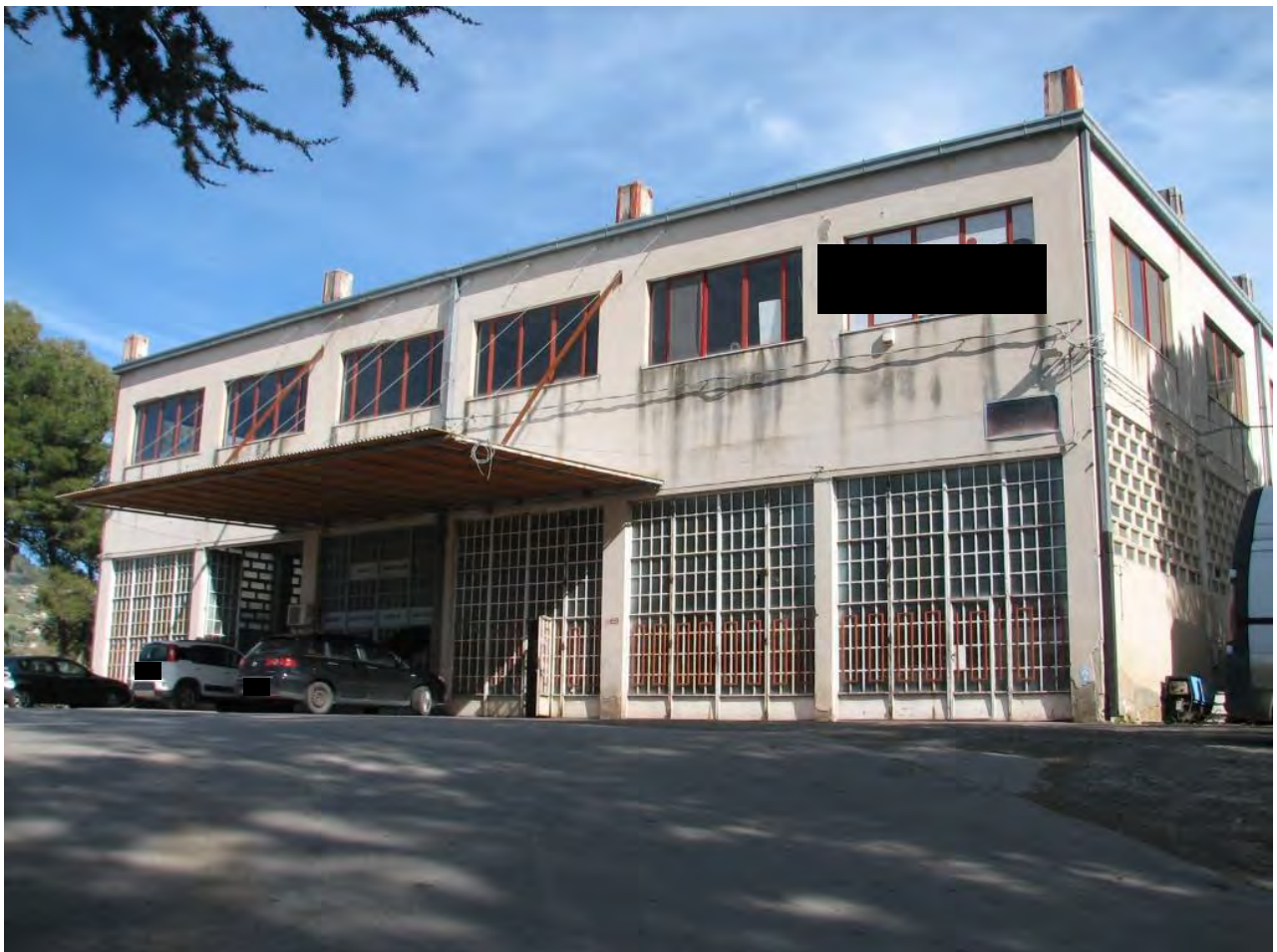
Foto 2 – Prospetto antistante dell'edificio (lato ovest)
