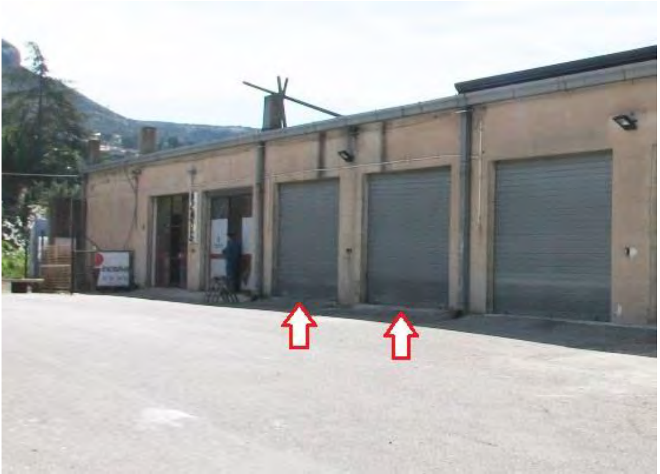
Foto 1 –Prospetto dell’autorimessa (corpo V) e doppio ingresso
