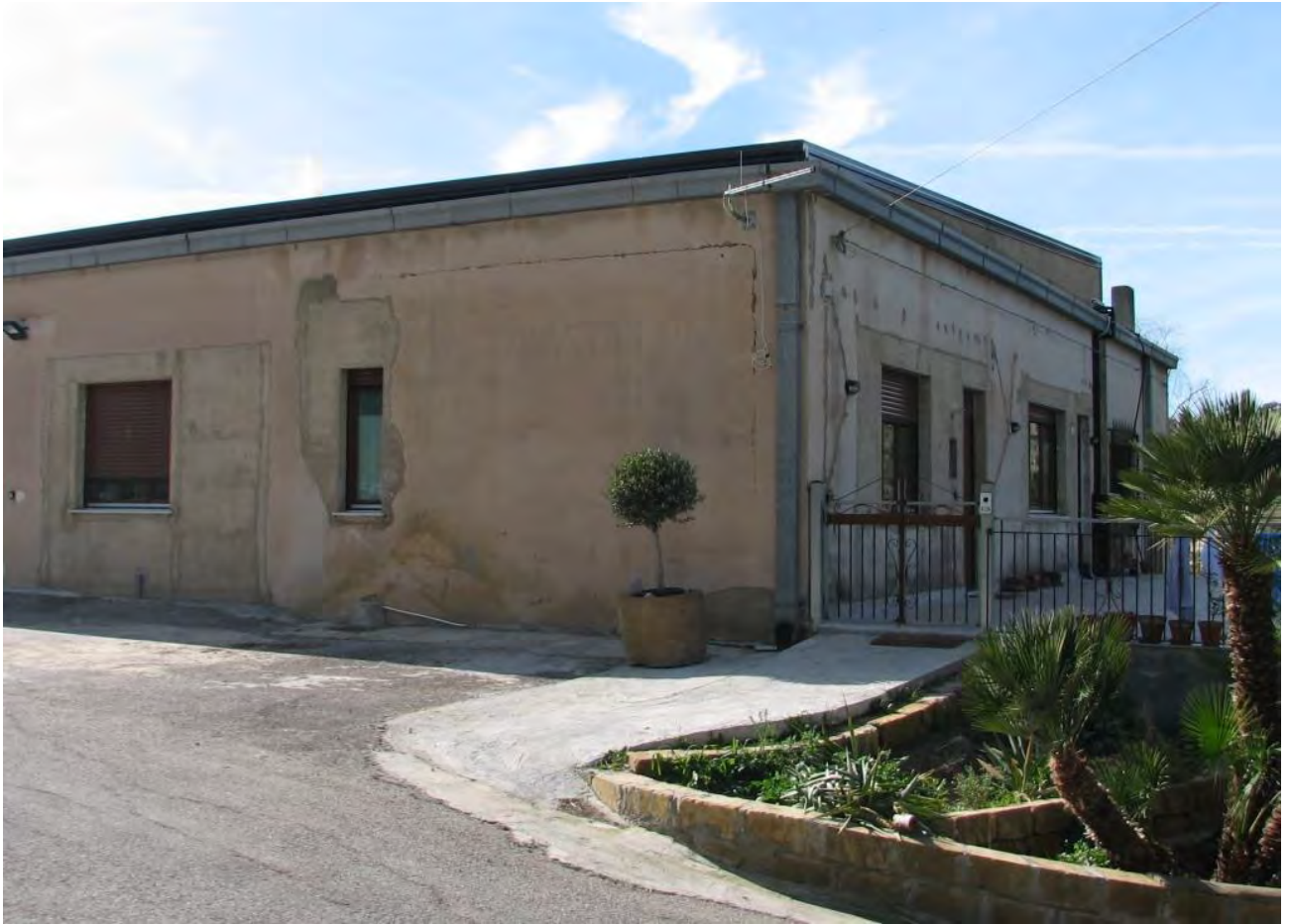
Foto 1 – Lati prospicienti dell'alloggio e ingresso dalla corte alla terrazza
