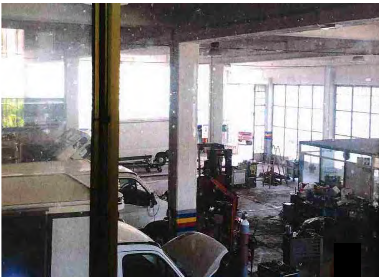
Foto 4 – locale principale dell'officina (visto dall'alto e verso le porte di accesso)
