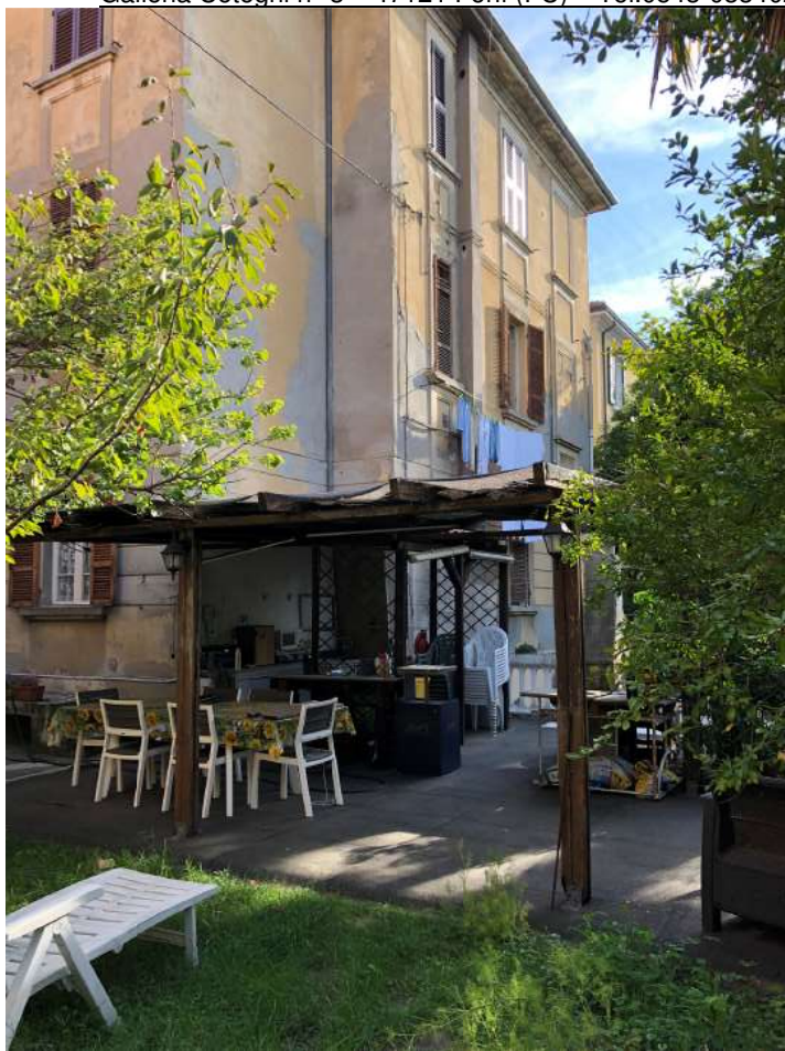
Foto 3- Retro prospetto e corte
