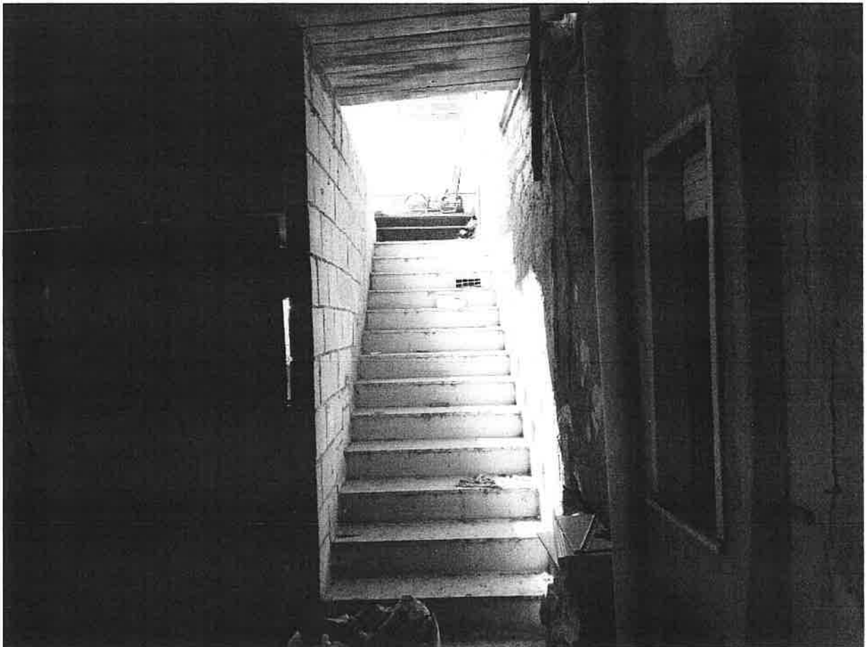
Foto 20 – Scala esterna posta sul retro del fabbricato
