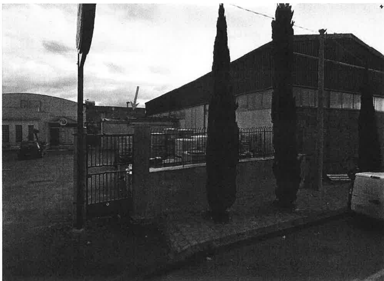
Foto 2 – Ingresso da viale del Cimitero al fabbricato pignorato
