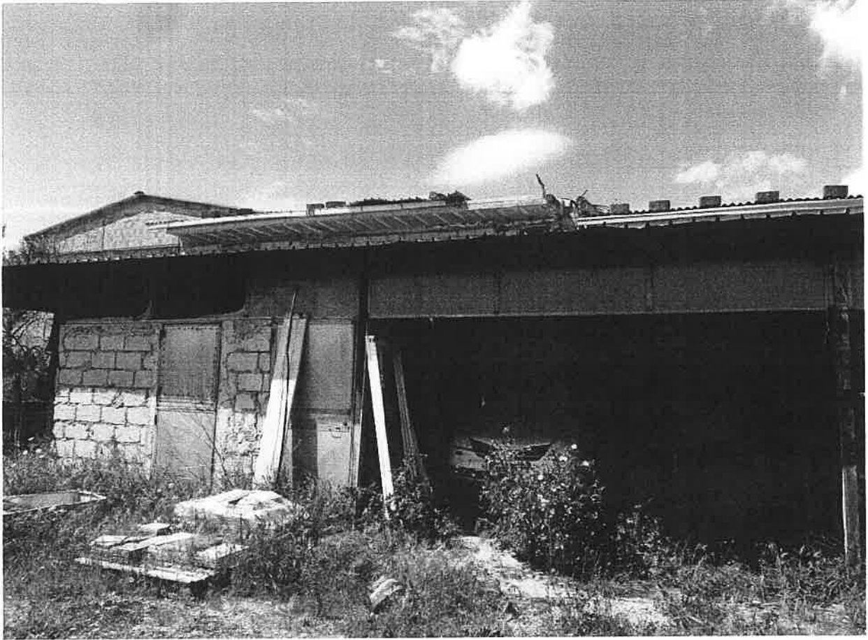
Foto 21 – Tettoia con manufatto in muratura all'interno ricadente nella part. 946
