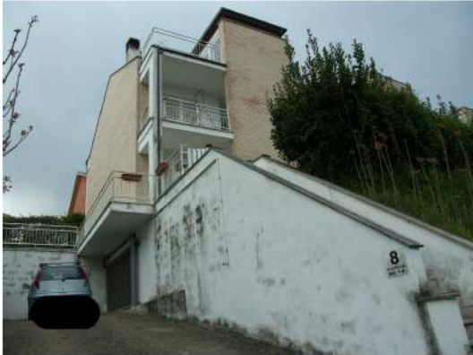
Scala accesso complesso immobiliare
