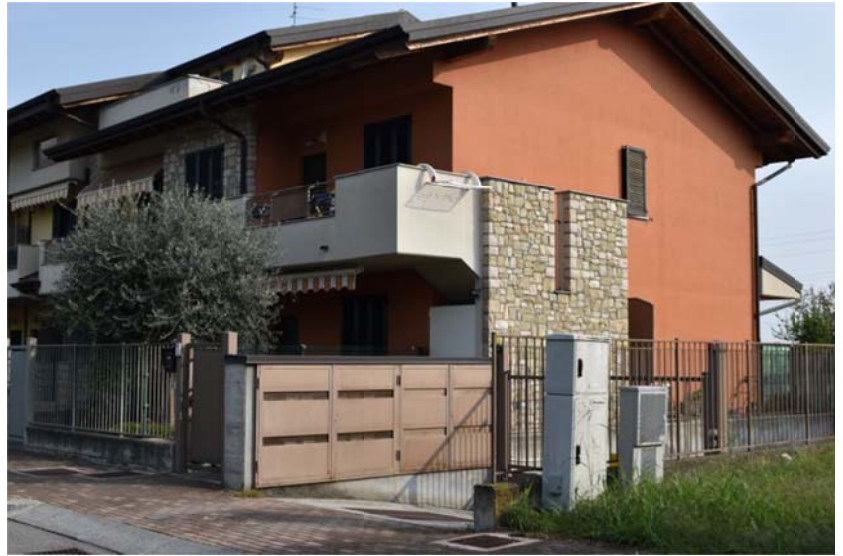
Foto n. 25 Vista dalla strada dell'appartamento mapp. 2892 sub 25
