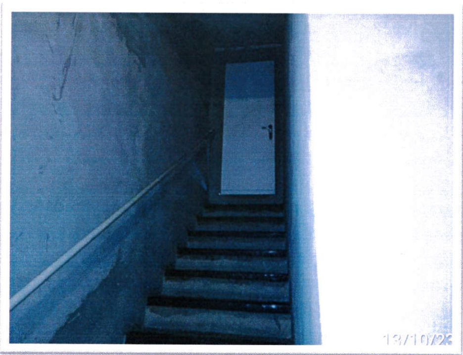
Scala di ingresso interna a garage e cantine
