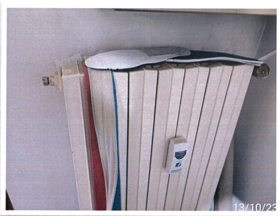
Particolare radiatore in ghisa con contabilizzatore di calore
