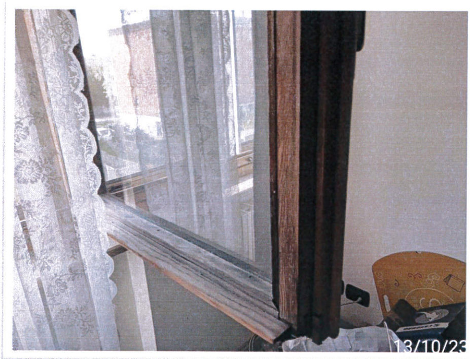
Particolare serramenti in legno vetro singolo
