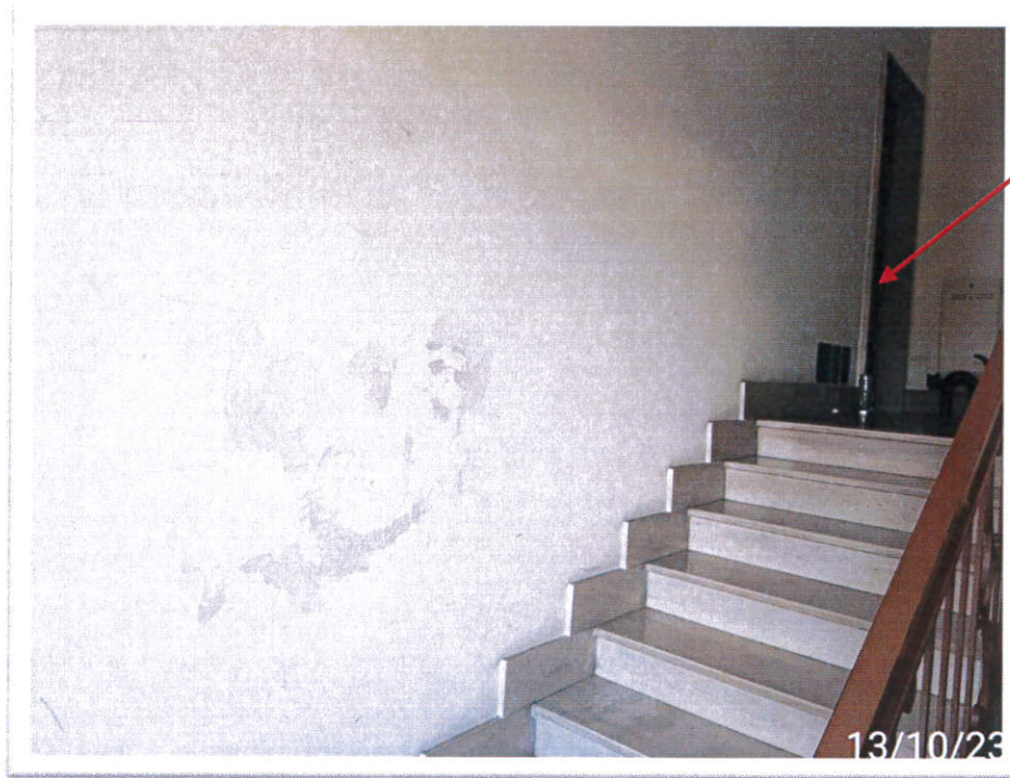
Scala condominiale – Intonaco ammalorato a causa di perdita di acqua tubazioni alloggio in oggetto
