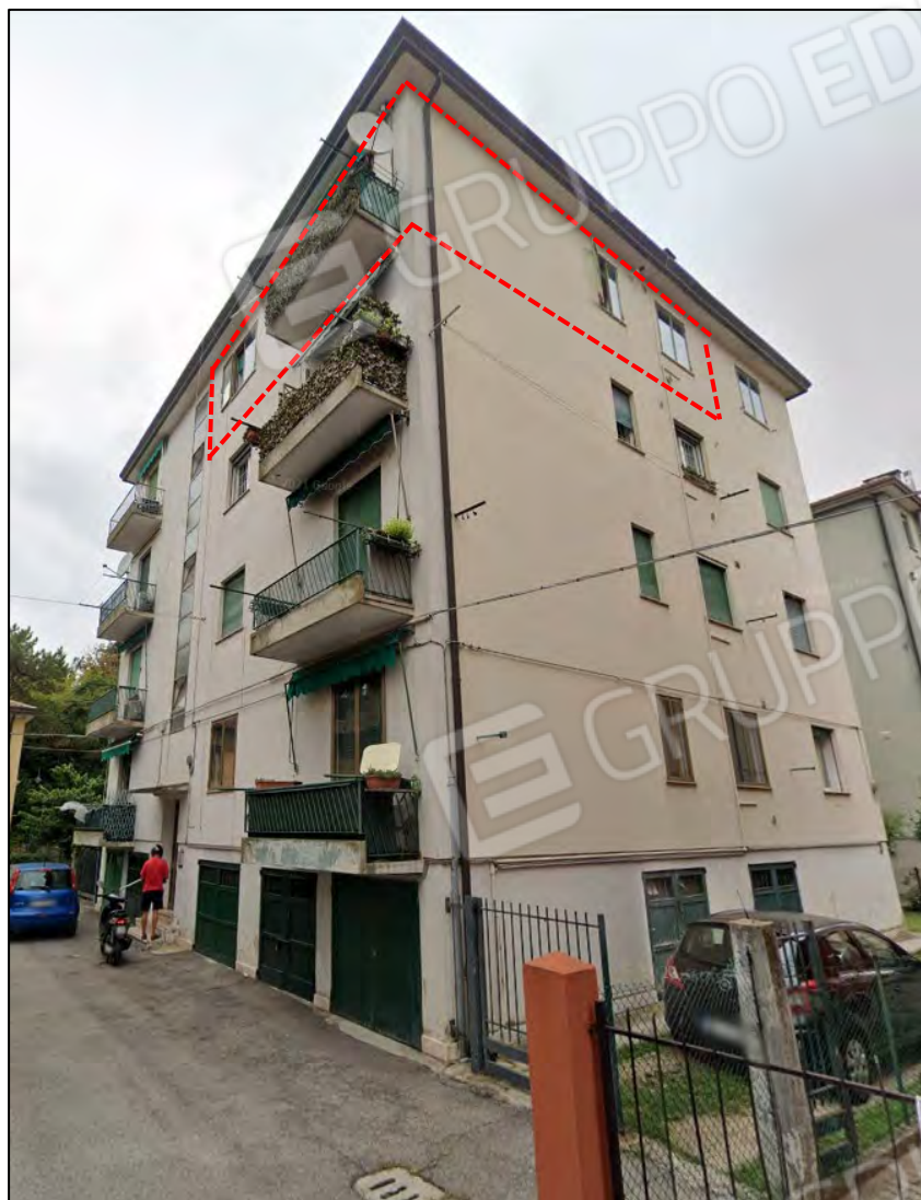
Foto 1 – esterno lato SUD-EST
