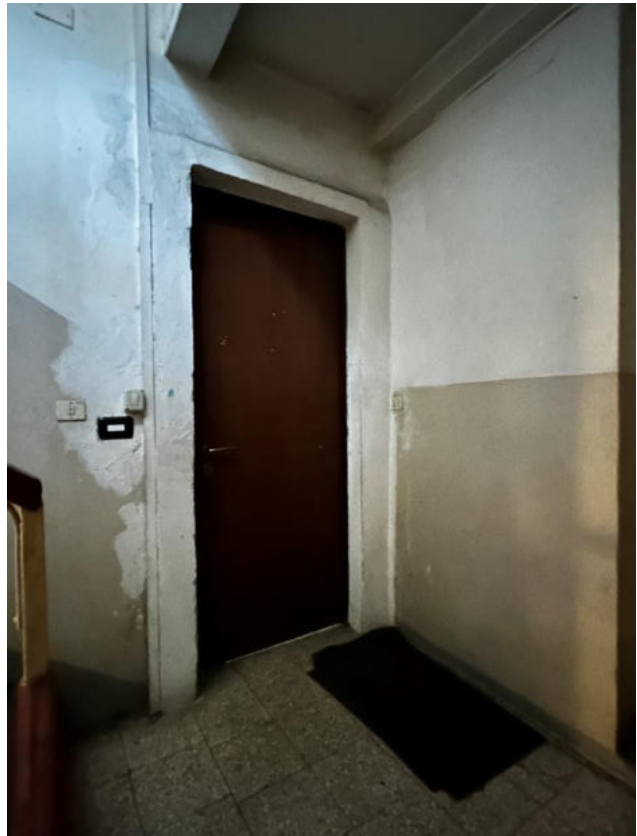
Ingresso appartamento (piano primo)
