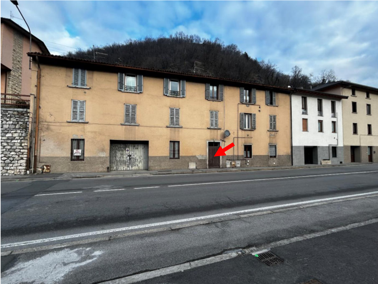
Ingresso fabbricato da via Cesare Battisti
