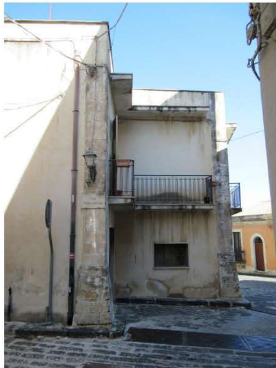
Foto 2_ Prospetto su Via Tranchina - Via Vittorio Emanuele
