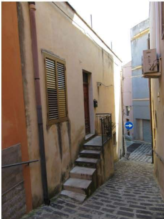
Foto 1_ Prospetto su Via Tranchina
