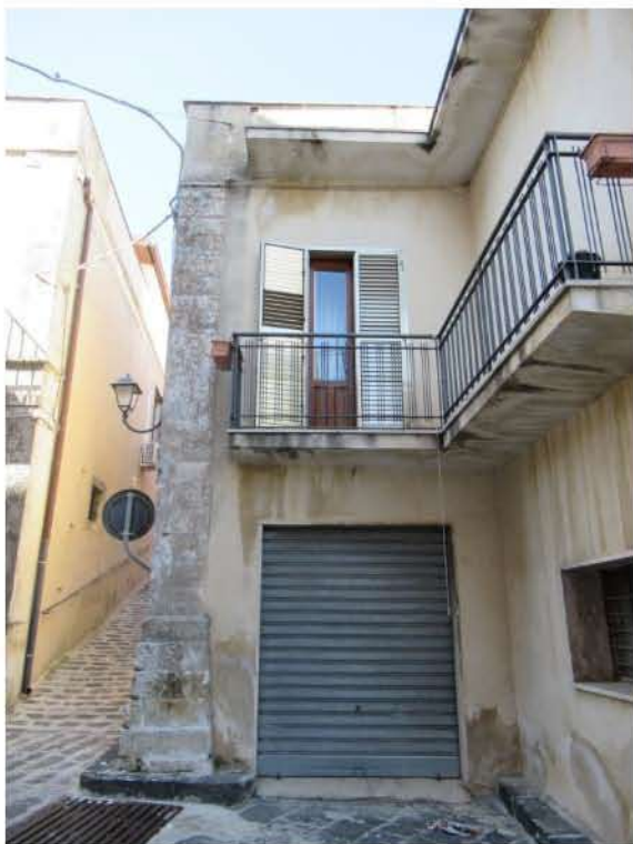
Foto 3_ Prospetto su Via Vittorio Emanuele
