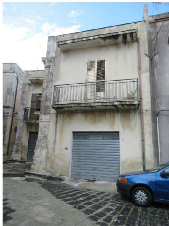
Foto 4_ Prospetto su Via Vittorio Emanuele
