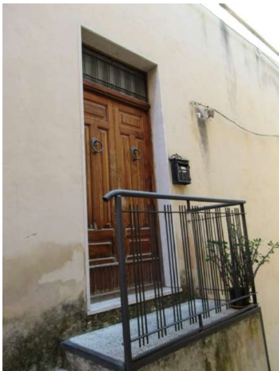
Foto 1_ Accesso da Via Tranchina
