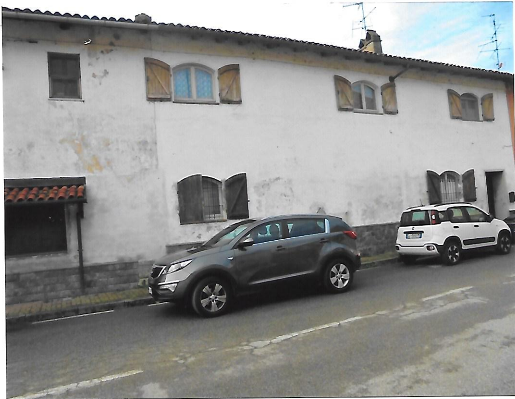
Foto 1- Fronte su Via Libertà,14
