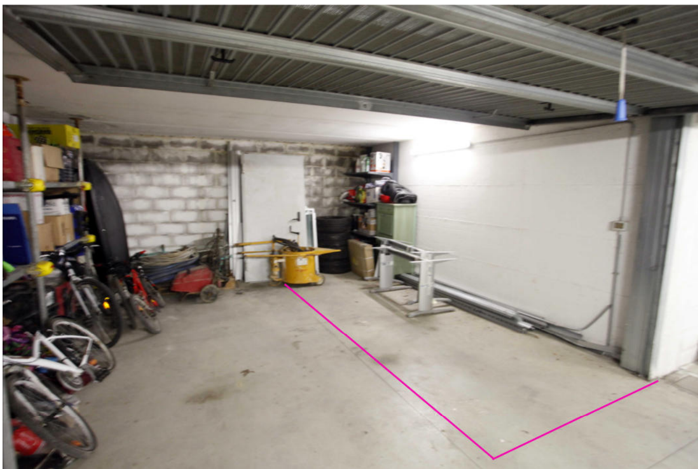
Vista interna dell'autorimessa con indicazione di massima del limite di proprietà
