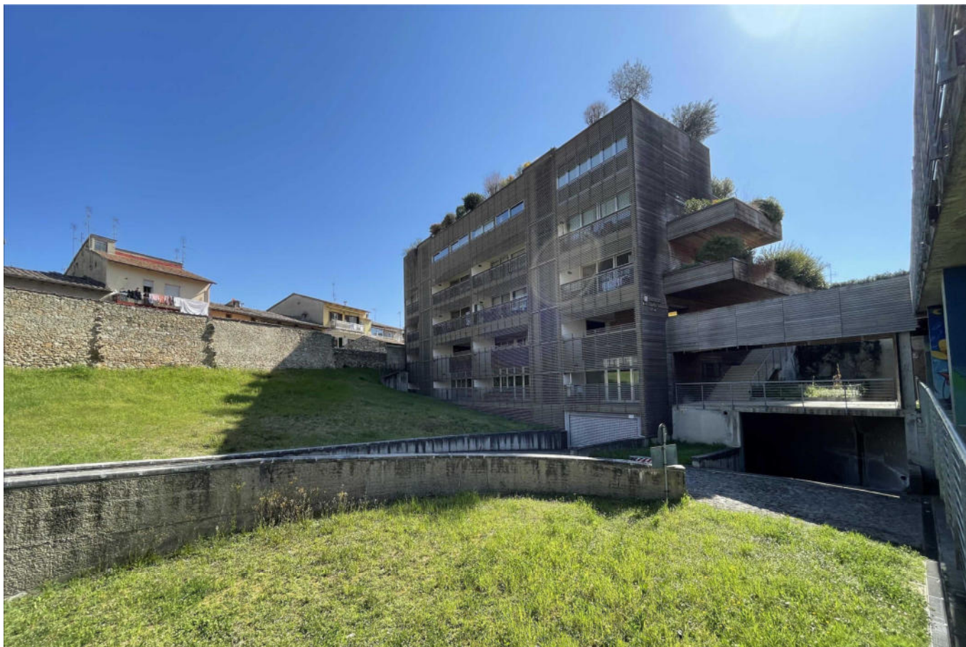
Vista dei fronti ovest e nord con gli accessi ai piani interrato e S2°
