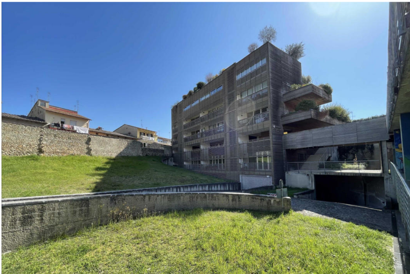
Vista dei fronti ovest e nord con gli accessi ai piani interrato e S2°
