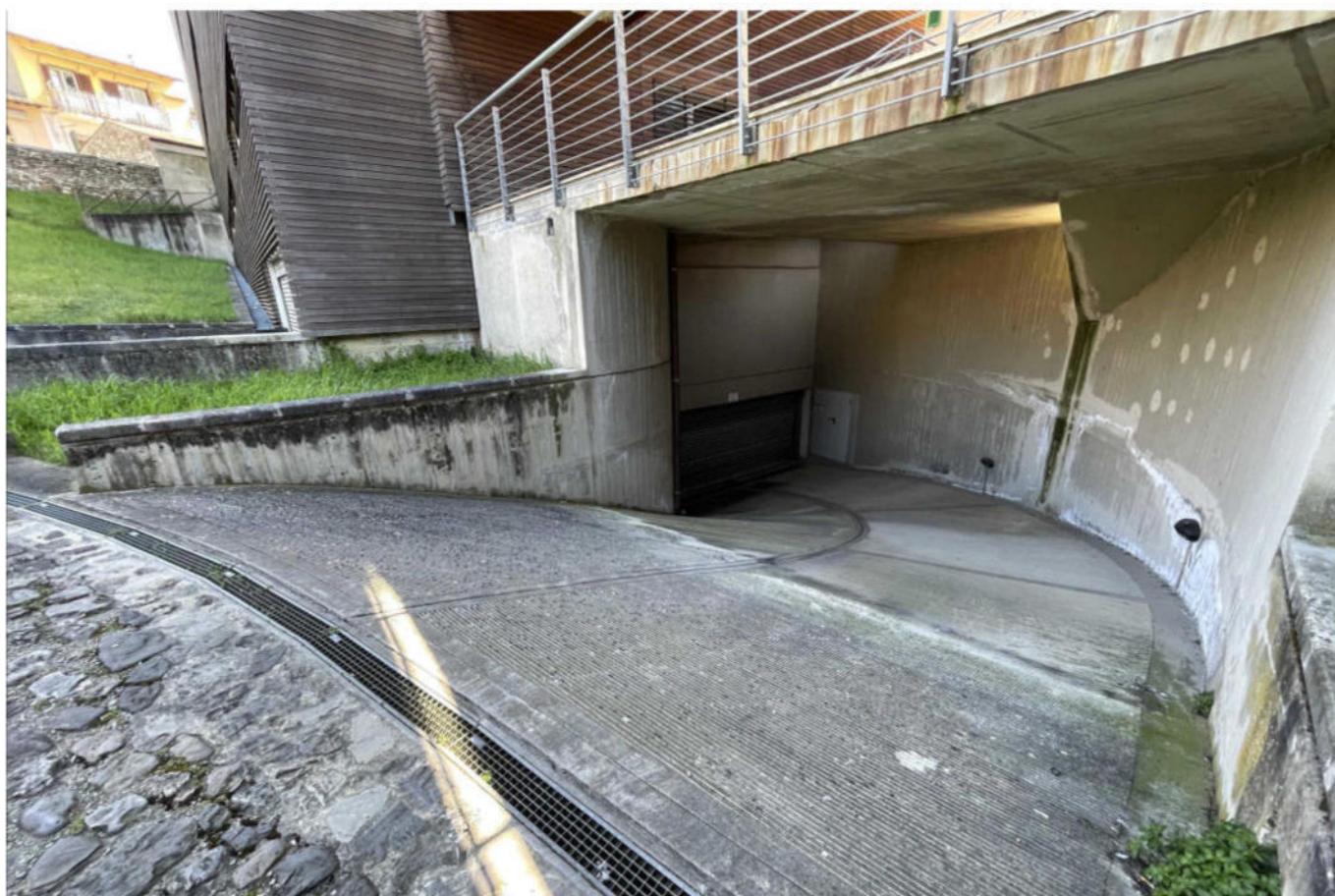
La rampa di accesso al piano interrato dove sono ubicate le autorimesse
