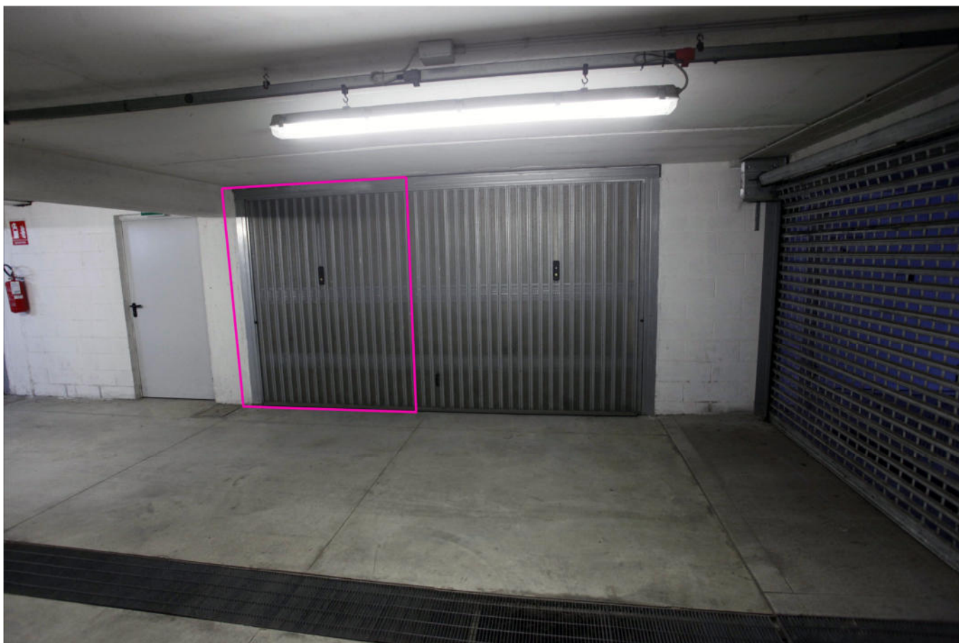
Vista della basculante dell'autorimessa con indicazione di massima del limite di proprietà
