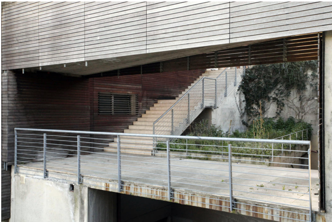
Vista degli esterni
