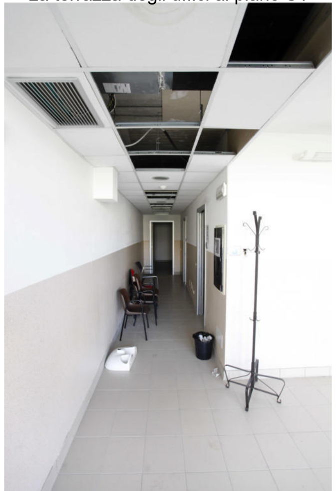
Ingresso e corridoio uffici al piano S1°
