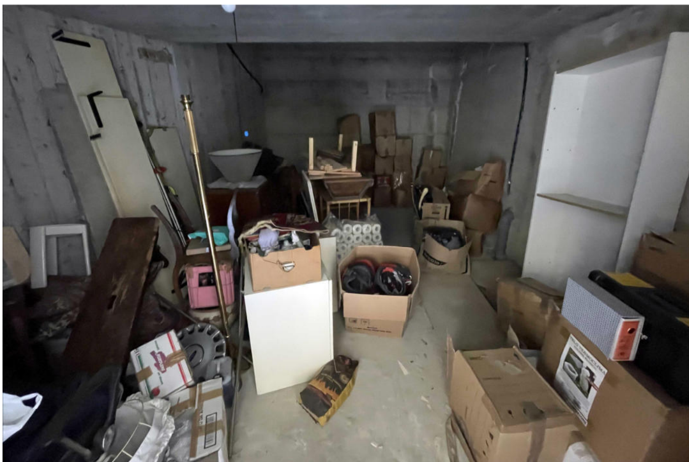
Il locale deposito al piano S2°
