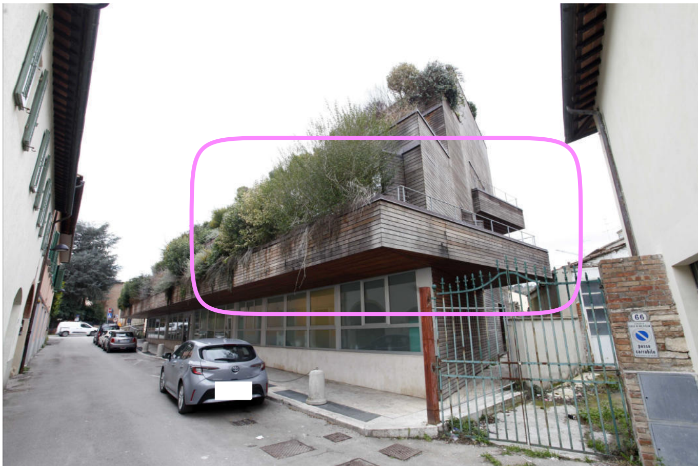
Vista dei fronti est e sud da via delle Casette
