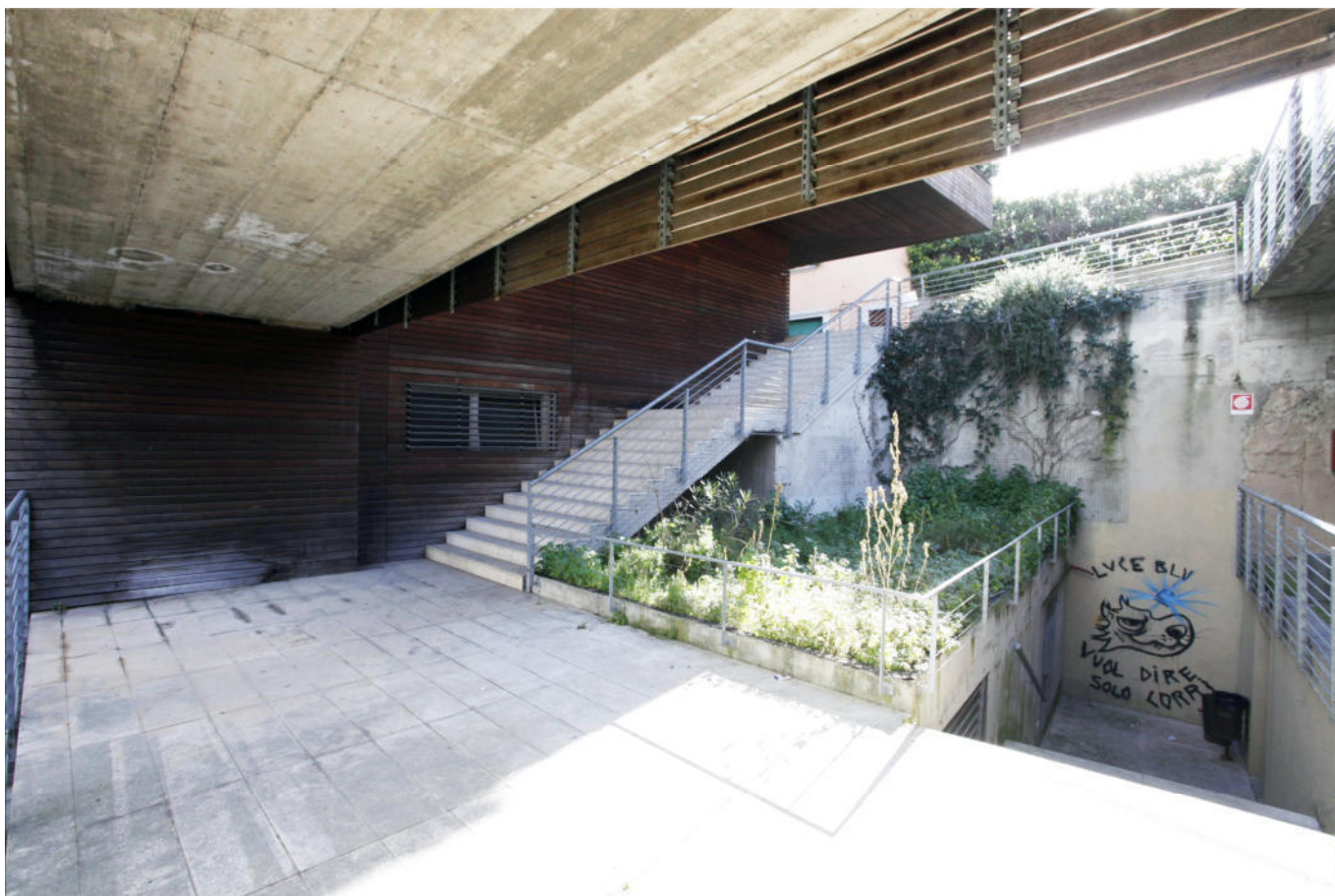
Vista degli esterni
