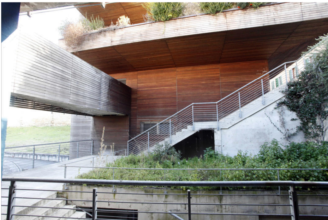
Vista degli esterni
