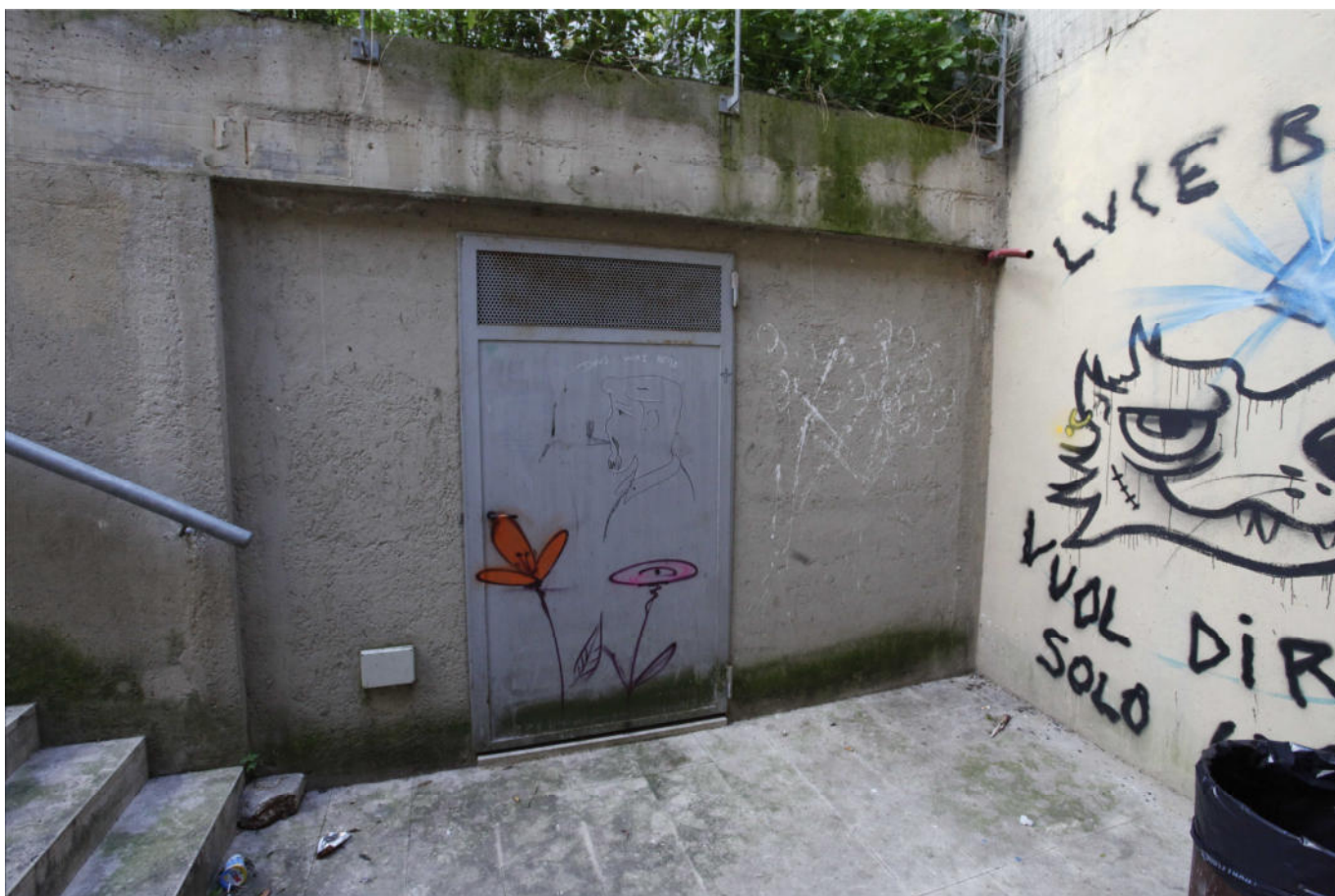
L'accesso al locale deposito al piano S2°
