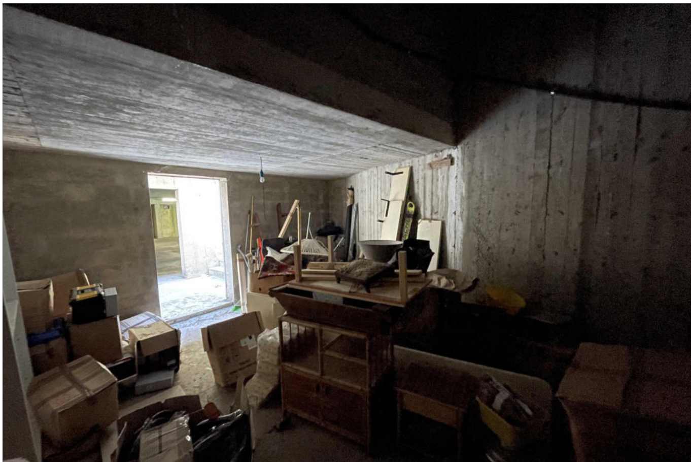
Il locale deposito al piano S2°
