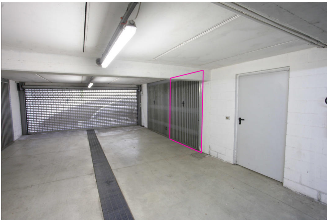
Vista della basculante dell'autorimessa con indicazione di massima del limite di proprietà
