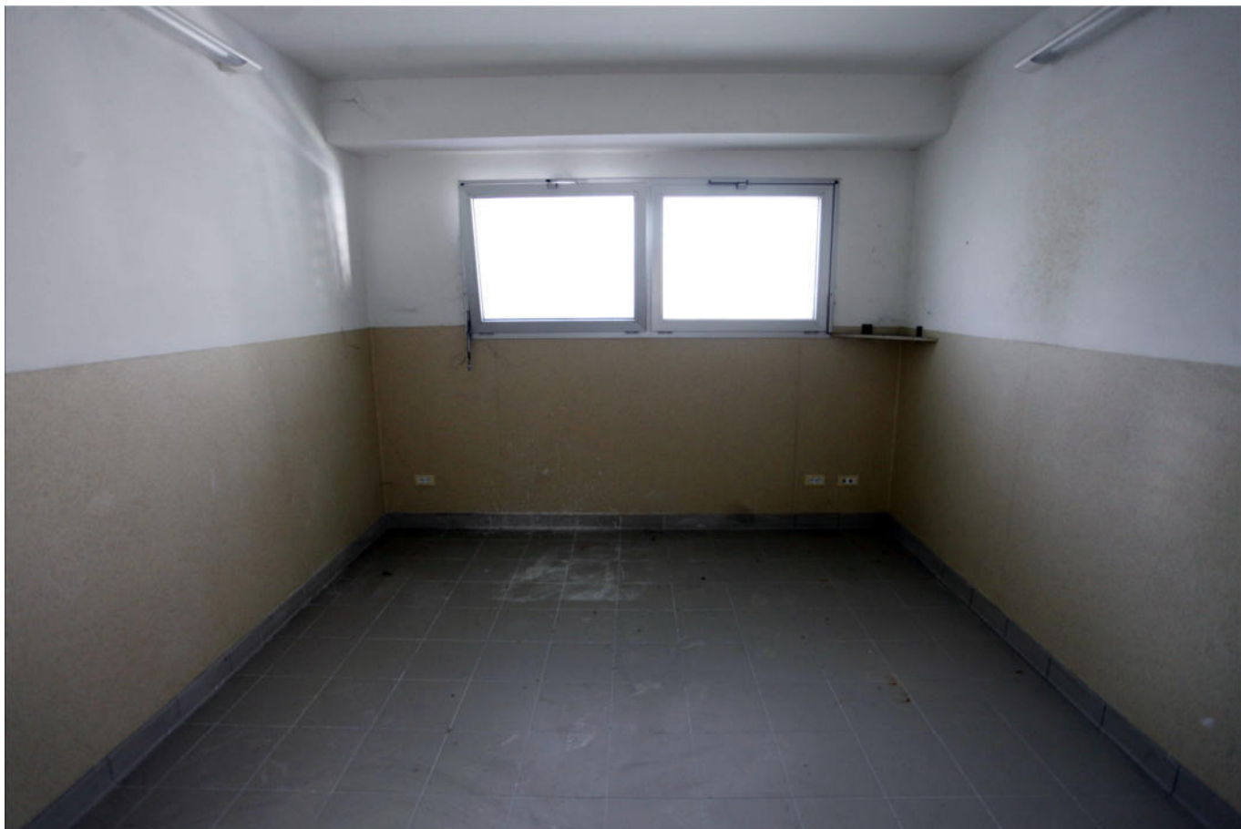
Uffici al piano S1°
