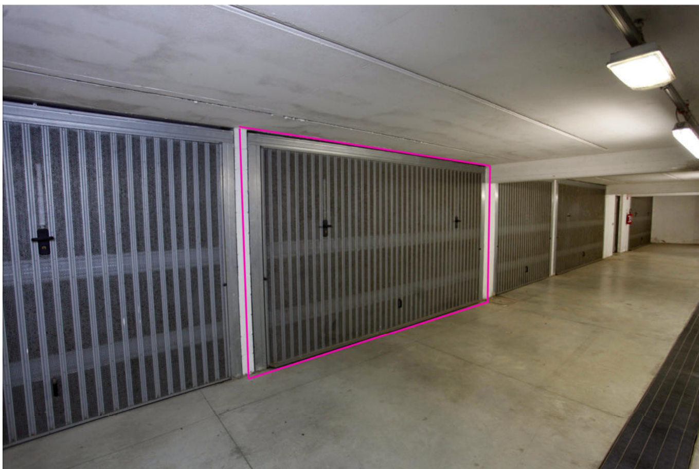
Vista della basculante al piano interrato con indicazione limite di proprietà
