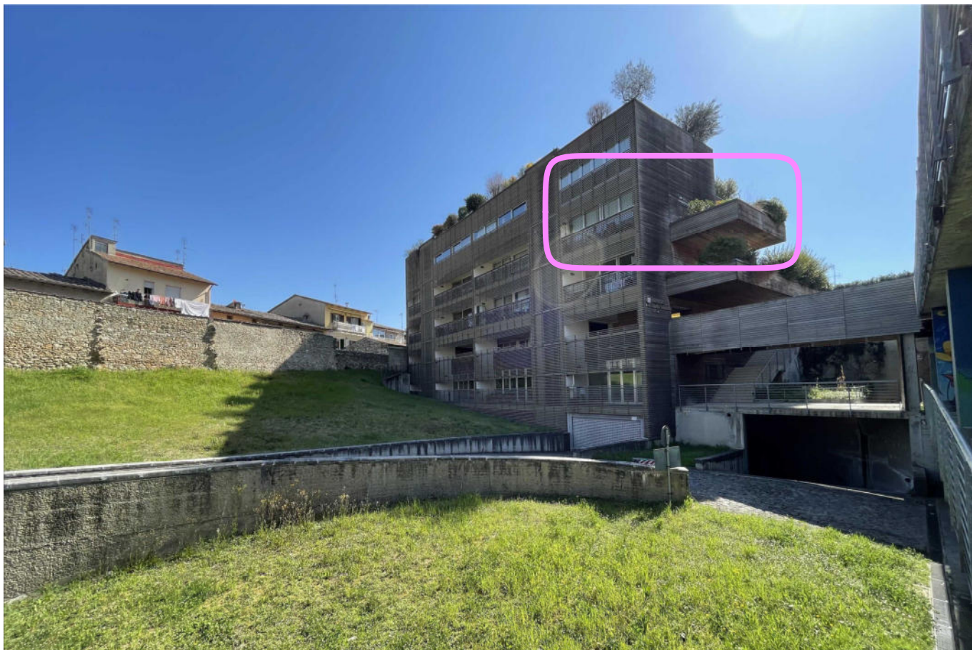
Vista dei fronti ovest e nord con gli accessi ai piani interrato e S2°
