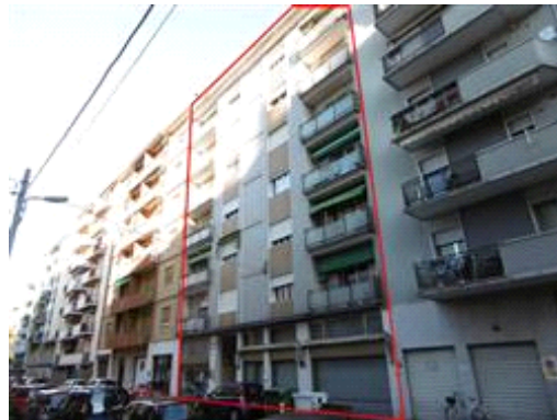
Edificio fronte strada
