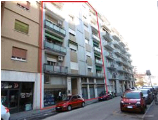
Edificio fronte strada
