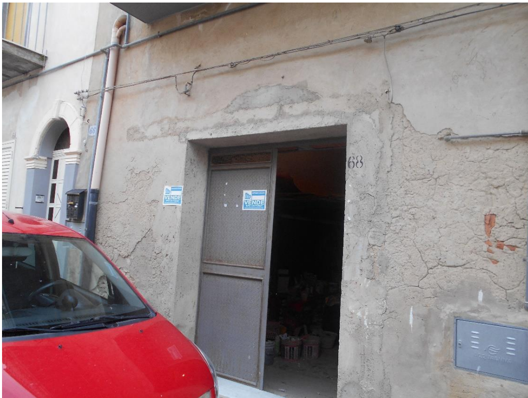
Foto 17 – Immobile 2_vista esterna
