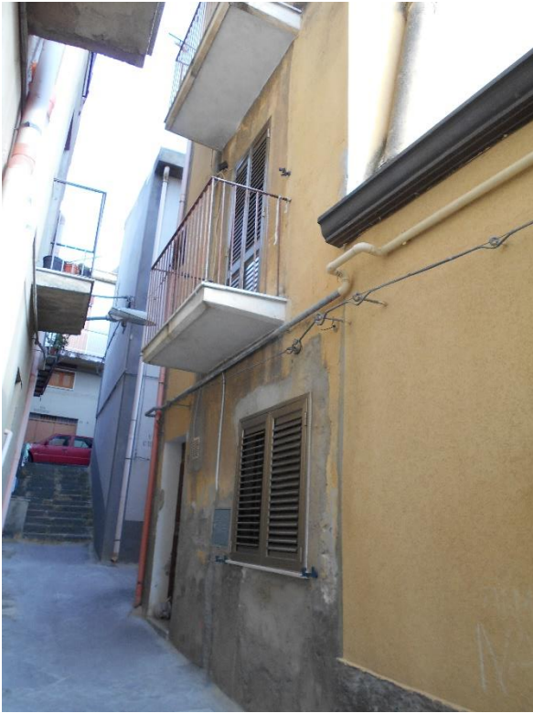
Foto 1 – Immobilità 1_Prospetto ovest
