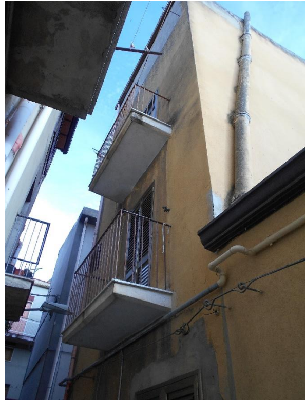
Foto 2 – Immobilità 1_Prospetto ovest
