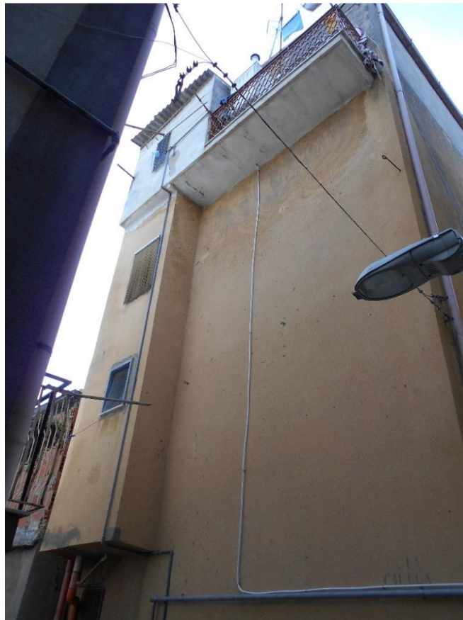
Foto 3 – Immobilità 1_Prospetto sud
