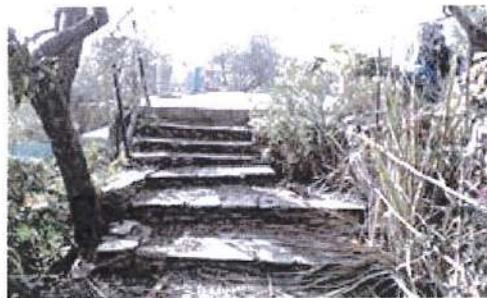
*il magazzino agricolo manca di interramento sull'estradosso del solaio (vedere progetto autorizzato)*
