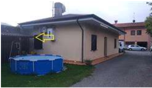
Tettoia non autorizzata
