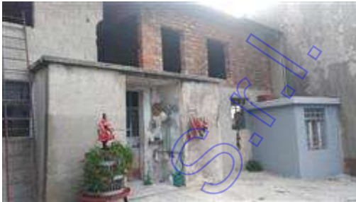
Veduta Corpo B
