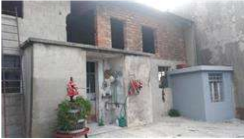
Veduta Corpo B
