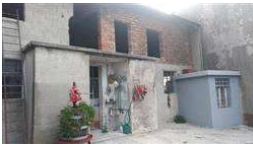
Veduta Corpo B
