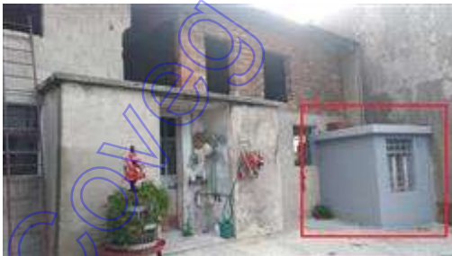
In evidenza il servizio igienico non autorizzato
