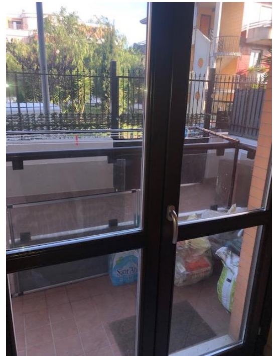
Vista dall'interno sui terrazzini che danno rispettivamente su Via De Rogati e Via Cicerale
