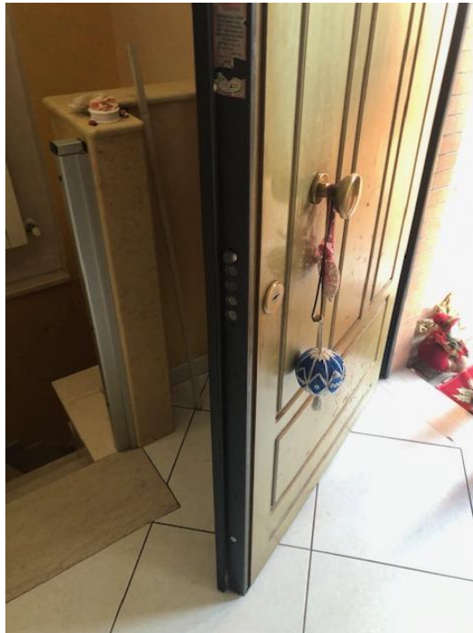
Dettaglio del portoncino di ingresso
