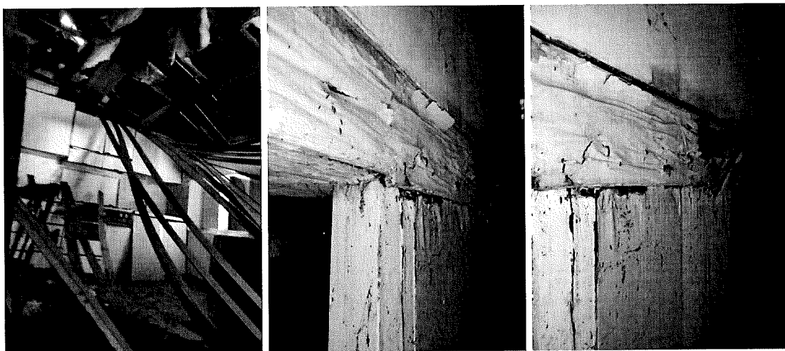
Mn. 1380 sub. 5: zona giorno e particolare travatura in legno del solaio 2^ piano (zona scala)
