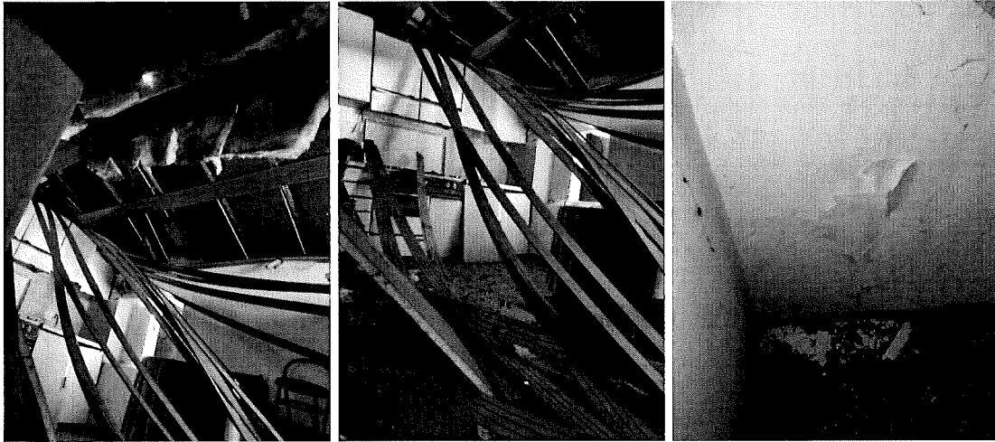
Copertura - pavimentazione Cucina - pareti vano scale
