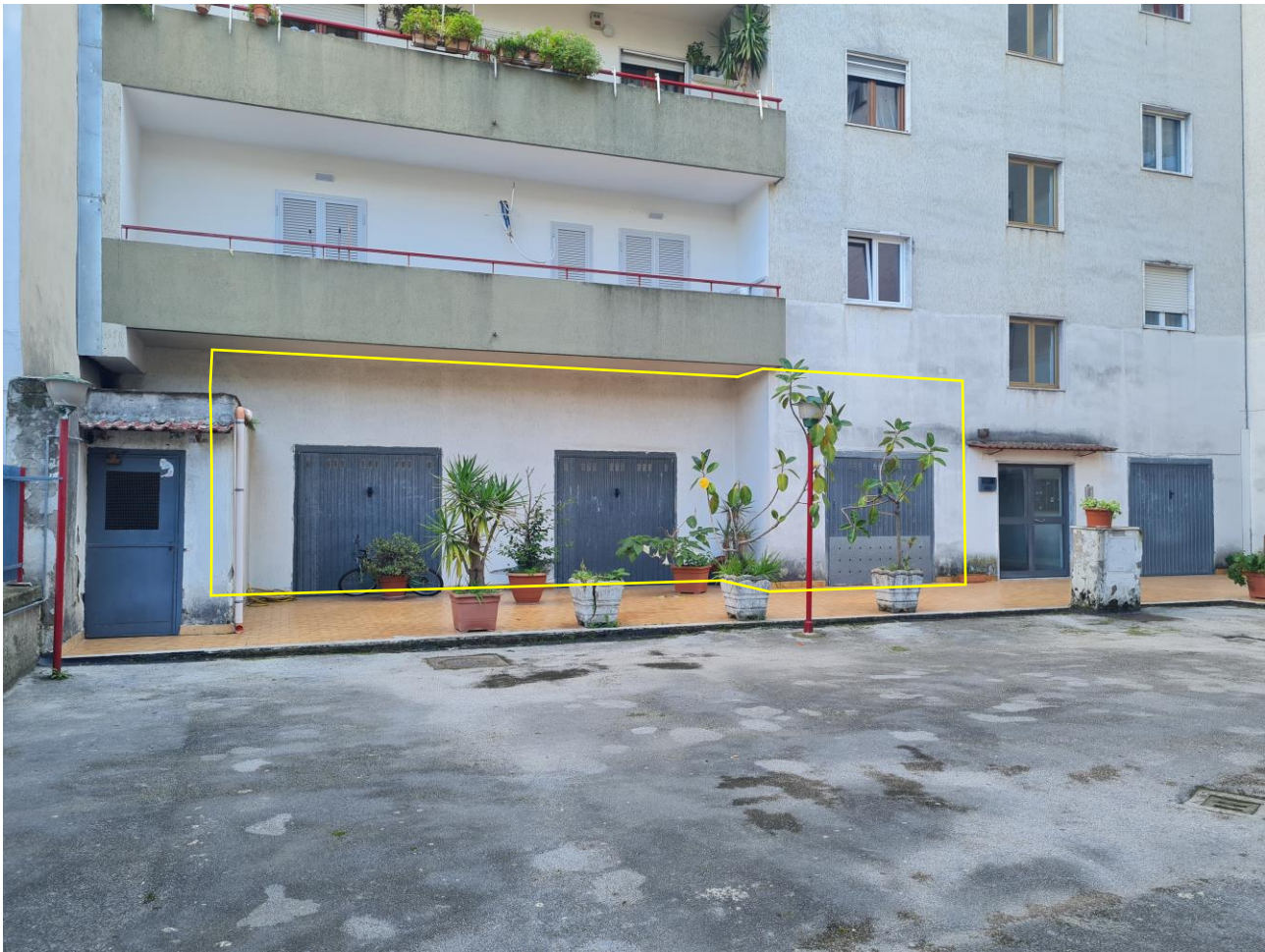
Prospetto posteriore sulla corte interna del Parco dei Fiori
