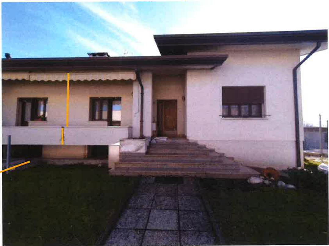
4.) ingresso piano primo
