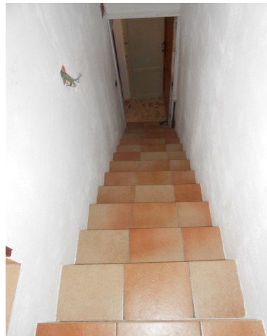
15. La scala interna dal 2° al 3° piano
