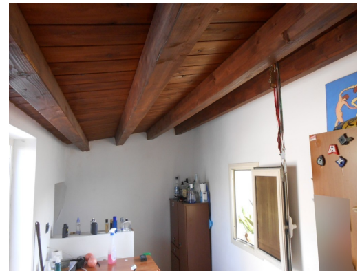
16. La cameretta sottotetto al 3° piano [parzialmente abusivo] vista verso l'arrivo della scala interna. A sinistra si nota l'accesso alla terrazza
