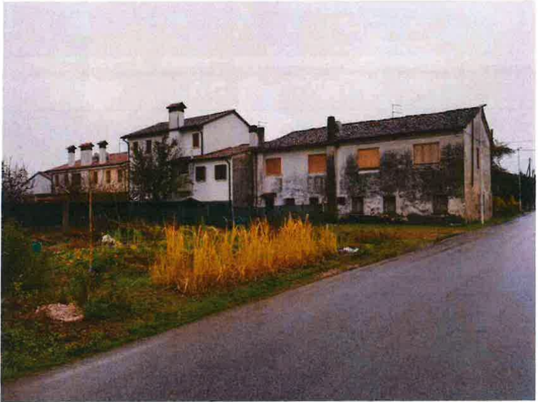
Vista nord-ovest fabbricato e terreno (mappale n. 983)
