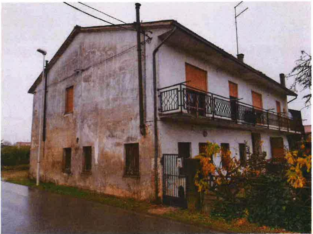
Vista sud-ovest fabbricato
