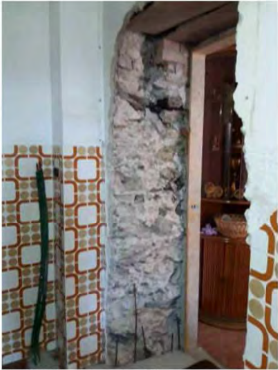
LOTTO 1: Piano primo - ripostiglio
