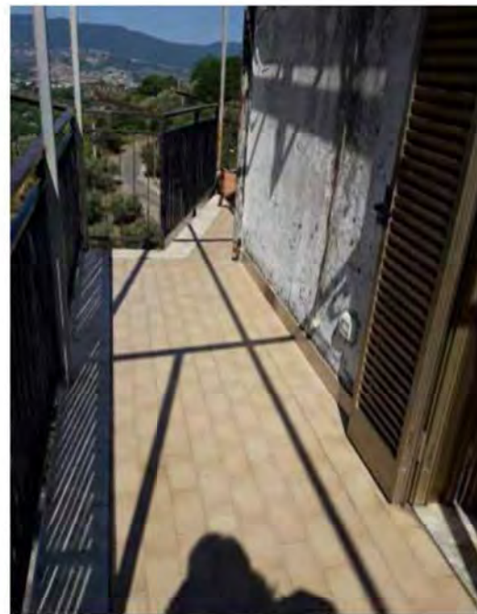
LOTTO 1: Piano sottotetto -balcone
