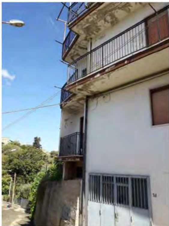
LOTTO 1: Prospetto laterale
