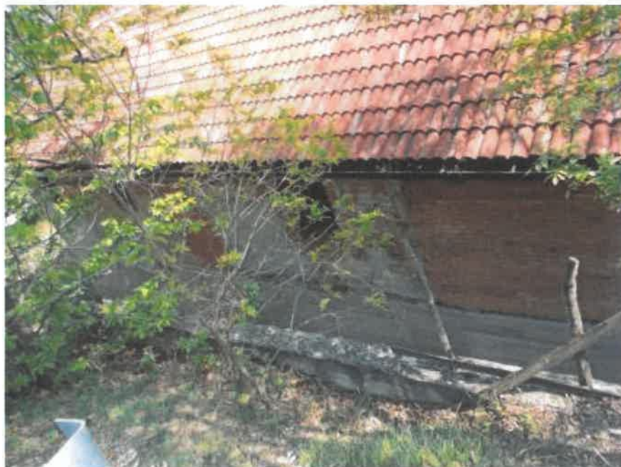
Foto 04- Immobile Censito al fg. 17 parrt.6 sub.1, vista dalla strada Provinciale SP.208
