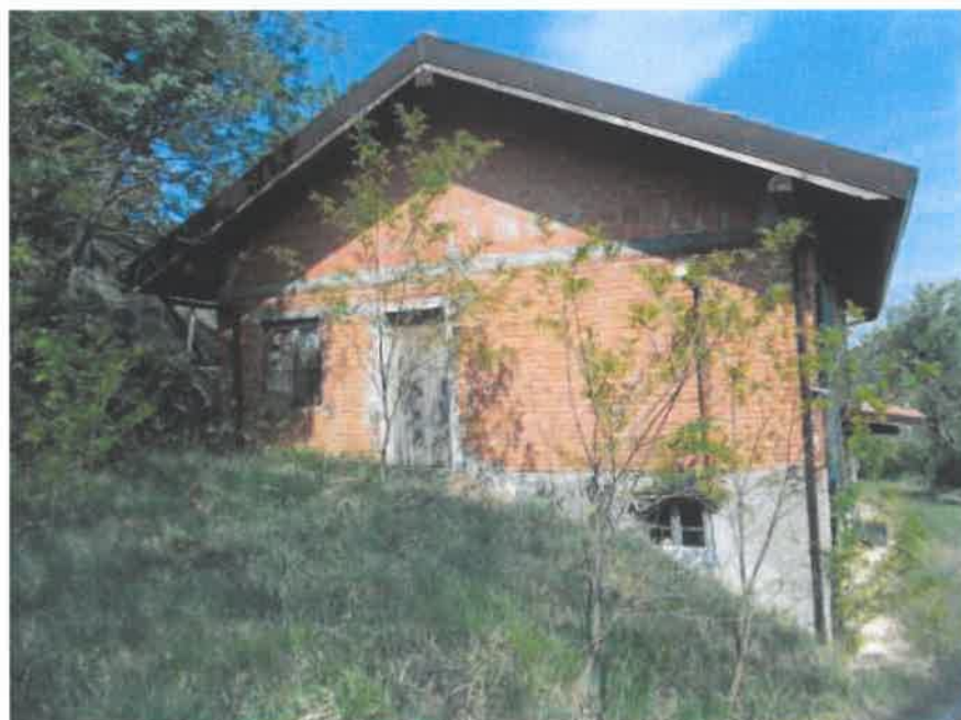
Foto 06 - immobile censito al fg.17 part.6 sub.1, vista dal cortile
