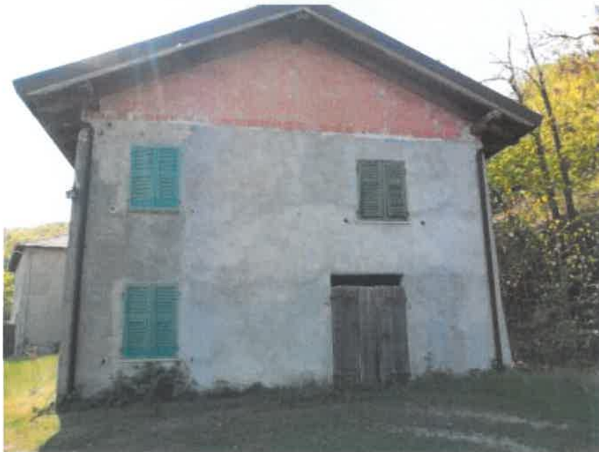
Foto 08- immobile censito al fg.17part.6 sub.1,
