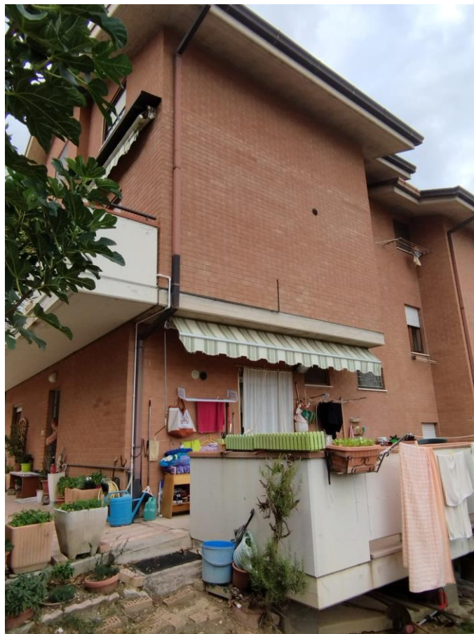
VISTA N.3 Terrazza e corte esclusiva con ingresso all'appartamento distinto al F.80 particella 447 sub 33 vista esterna dal lato est;
