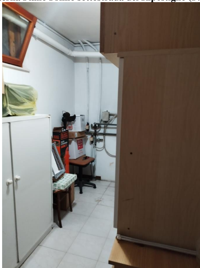
VISTA N.8 Foto interna Piano Primo sottostrada del Ripostiglio con Centrale termica (F.80 part. 447 sub.33);
