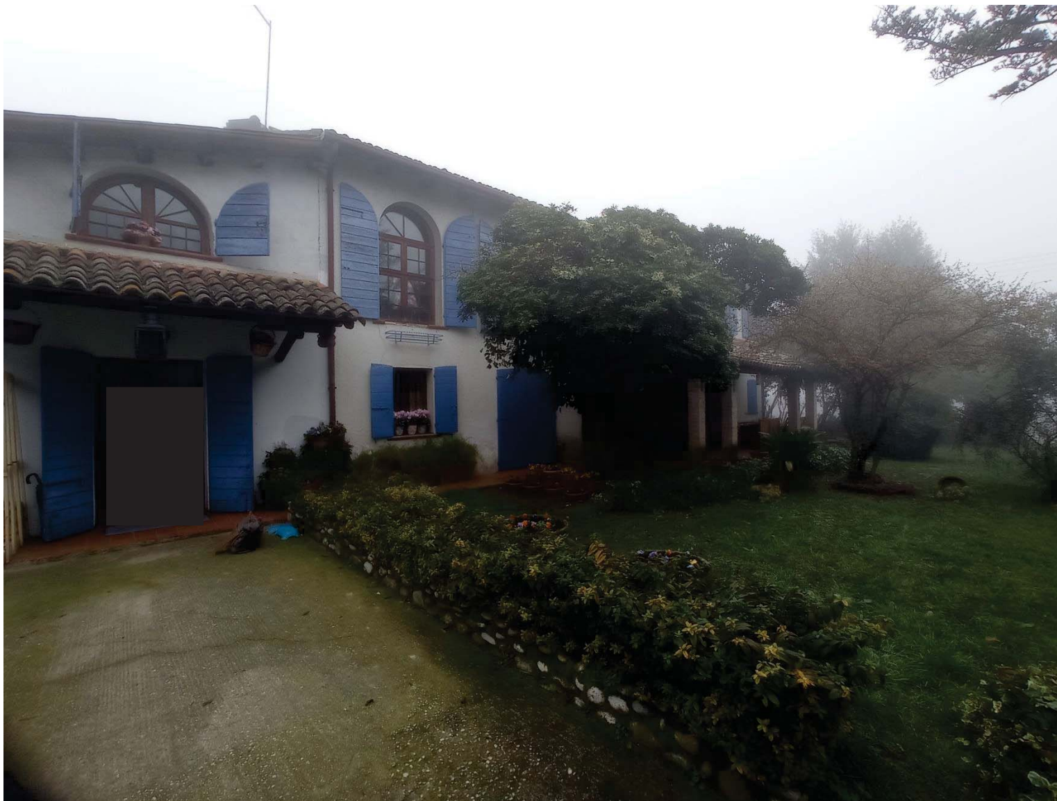
Foto 5 – Vista del fabbricato parte ovest
