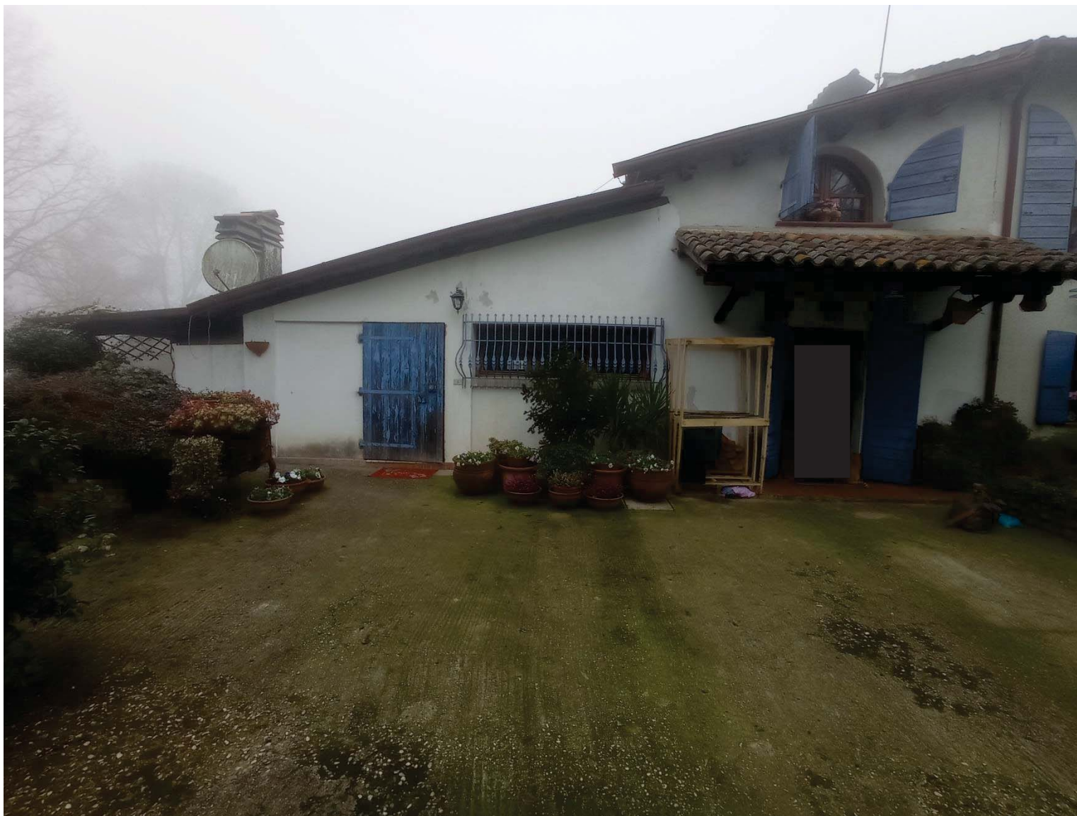
Foto 4 – Vista del fabbricato parte est
