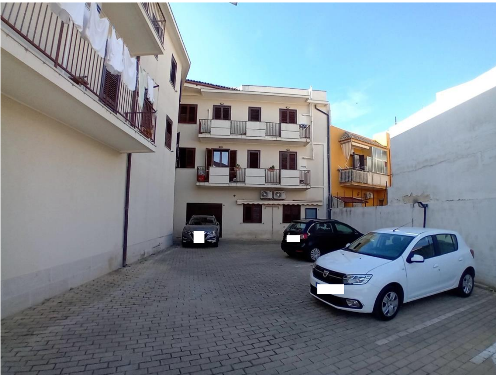
Fot.n°10: prospetto principale su corte interna, vista generale
