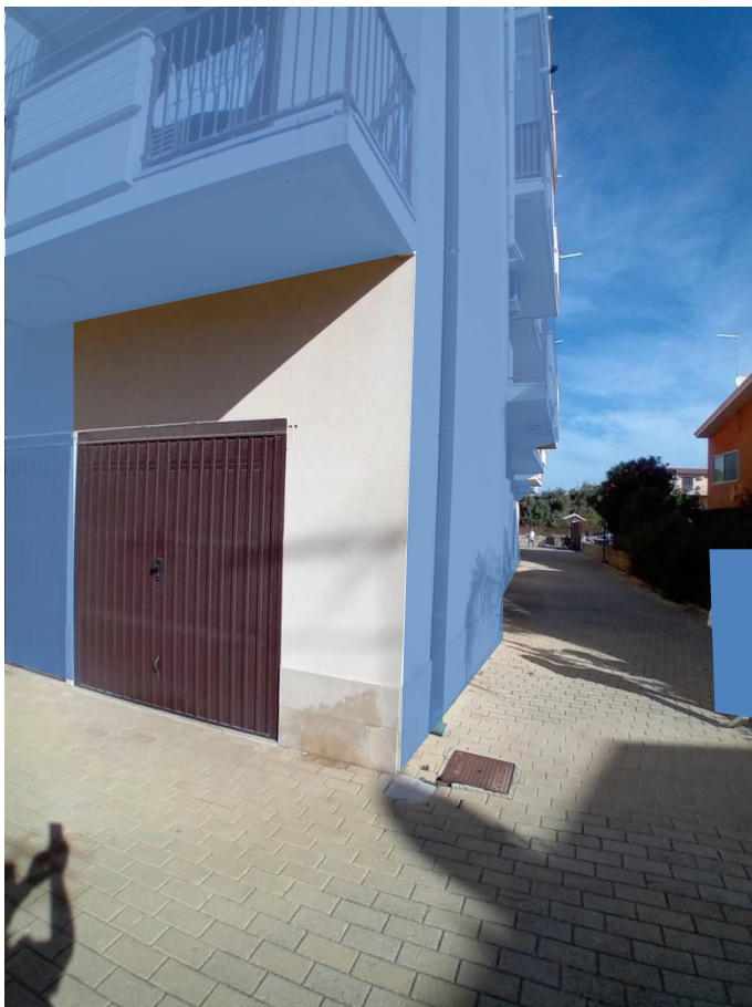
Fot.n°1: accesso autorimessa dal civico 31/B di Via Siracusa
