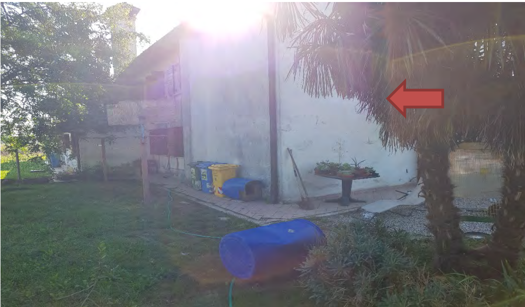
VISTA LATI OVEST E NORD
