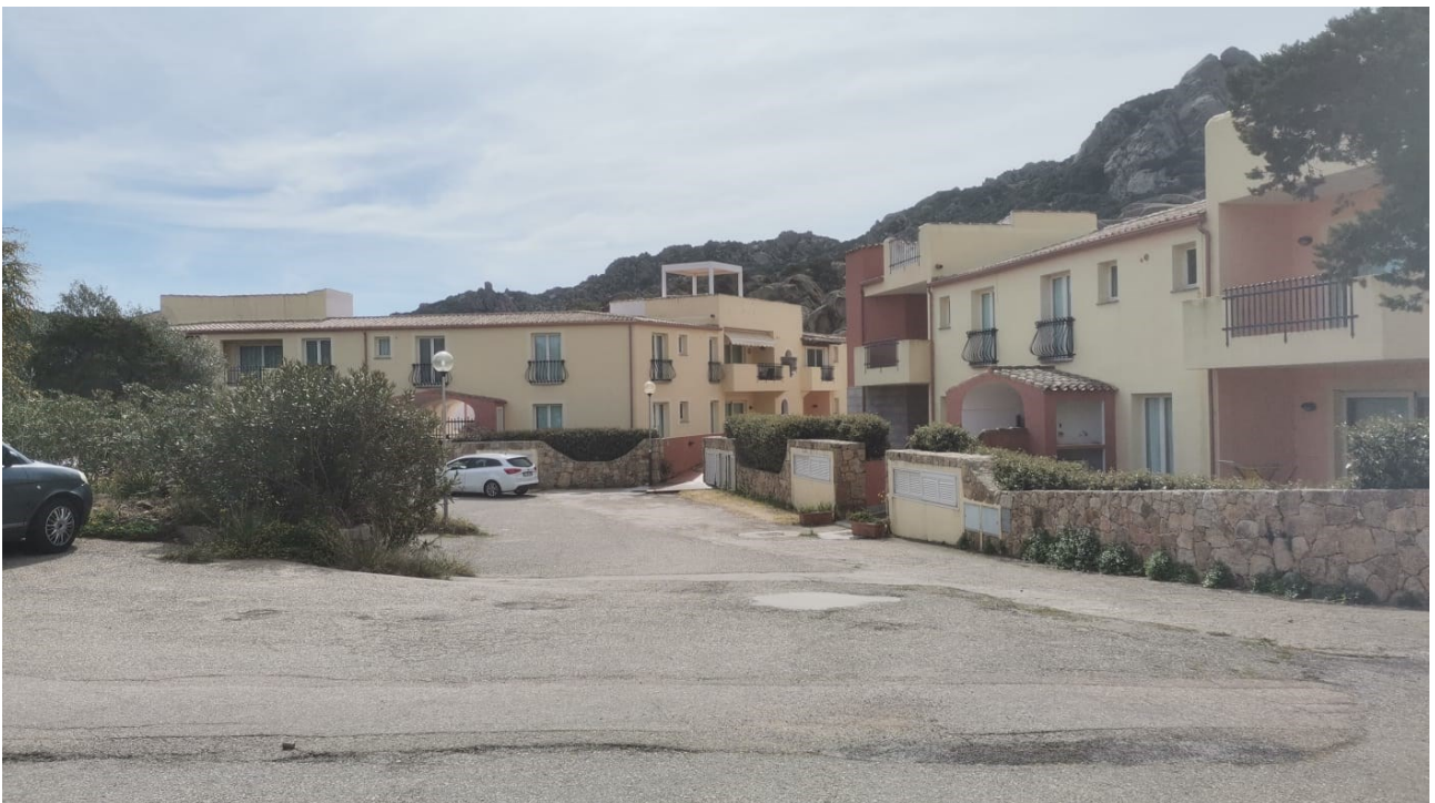
FIGURA 2:INGRESSO AL COMPRESO LE CASE DI PIETRA
