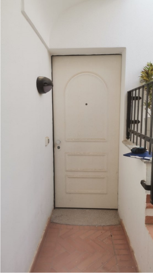
FIGURE 7: ACCESSO AL SUB. 33 (APPARTAMENTO)
