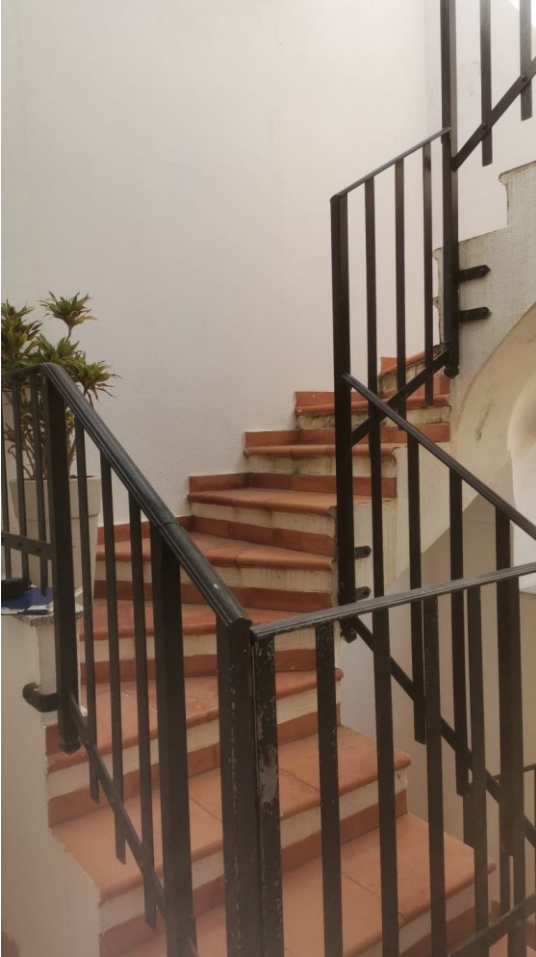
FIGURE 20: A) SCALE DI ACCESSO ALLA COPERTURA;
