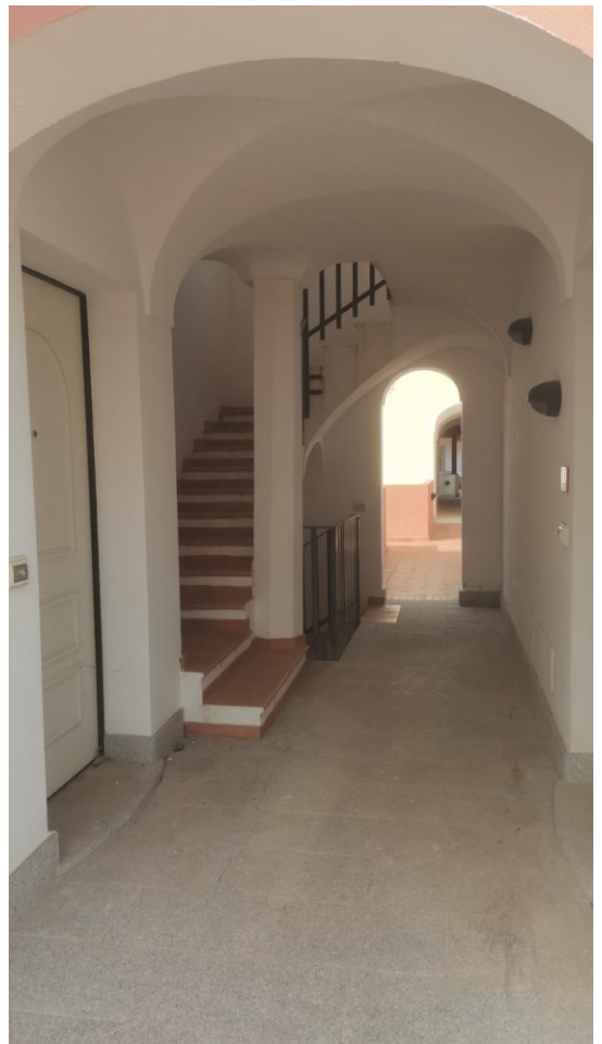
B) PASSAGGIO AL VANO SCALA
