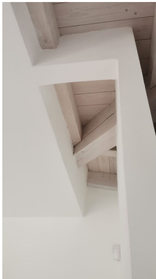
B) DETTAGLIO ATTACCO SOLAIO
