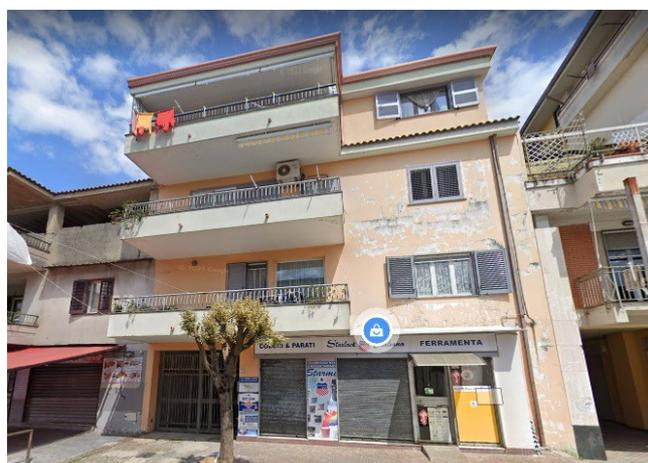
L'appartamento di causa fa parte di un fabbricato, costruito a partire dal 1981, di quattro piani fuori terra, di cui l'ultimo sottotetto, mostrato nella foto qui di fianco; trattasi di una struttura a pilastri e travi in c.a., con pareti di tompagno rivestite di malta ordinaria di colore rosa e balconi grigio chiaro. L'accesso al fabbricato avviene da via Massimo Stanzione n° 24, attraverso un portone pedonale e carrabile (*cf.* Allegato 1: Foto: 5),
