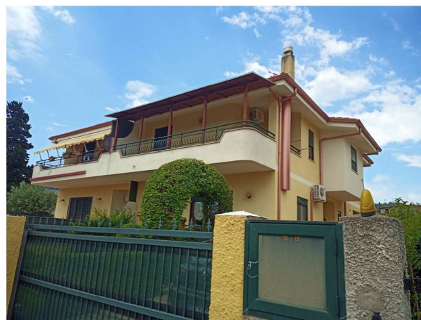
Ingresso Sud Carrabile
