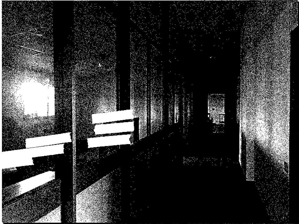
FOTO 16 - INTERNO LOCALE PRIMO
