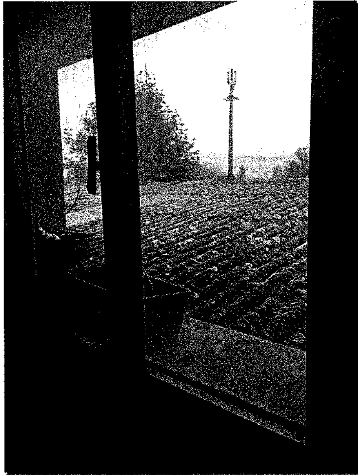
FOTO 11 – VISTA DA INTERNO LOCALE PIANO PRIMO (SU COPERTURA IN CEMENTO AMIANTO)
