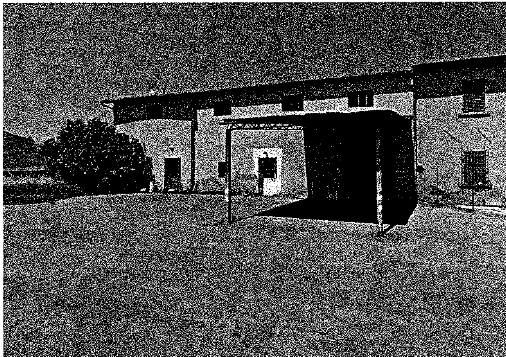
VISTA DELL'INGRESSO AL FABBRICATO DAL PIAZZALE ANTISTANTE
