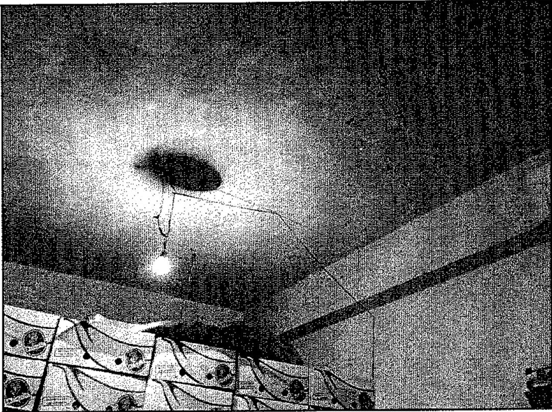
Foto n. 5: Particolare dell'impianto elettrico non conforme alla normativa vigente
