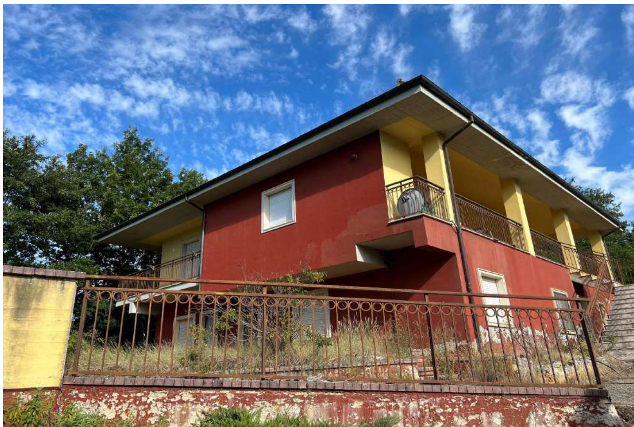
FOTO 1: Veduta esterna lato sud-est
