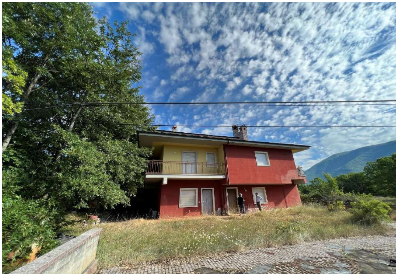
FOTO 3: Veduta esterna lato sud-ovest
