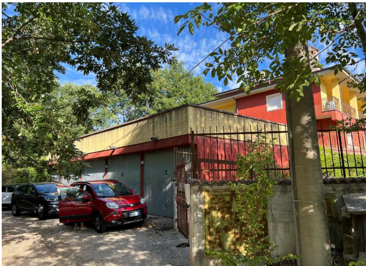
FOTO 6: Veduta esterna garage interrati su via Defensa
