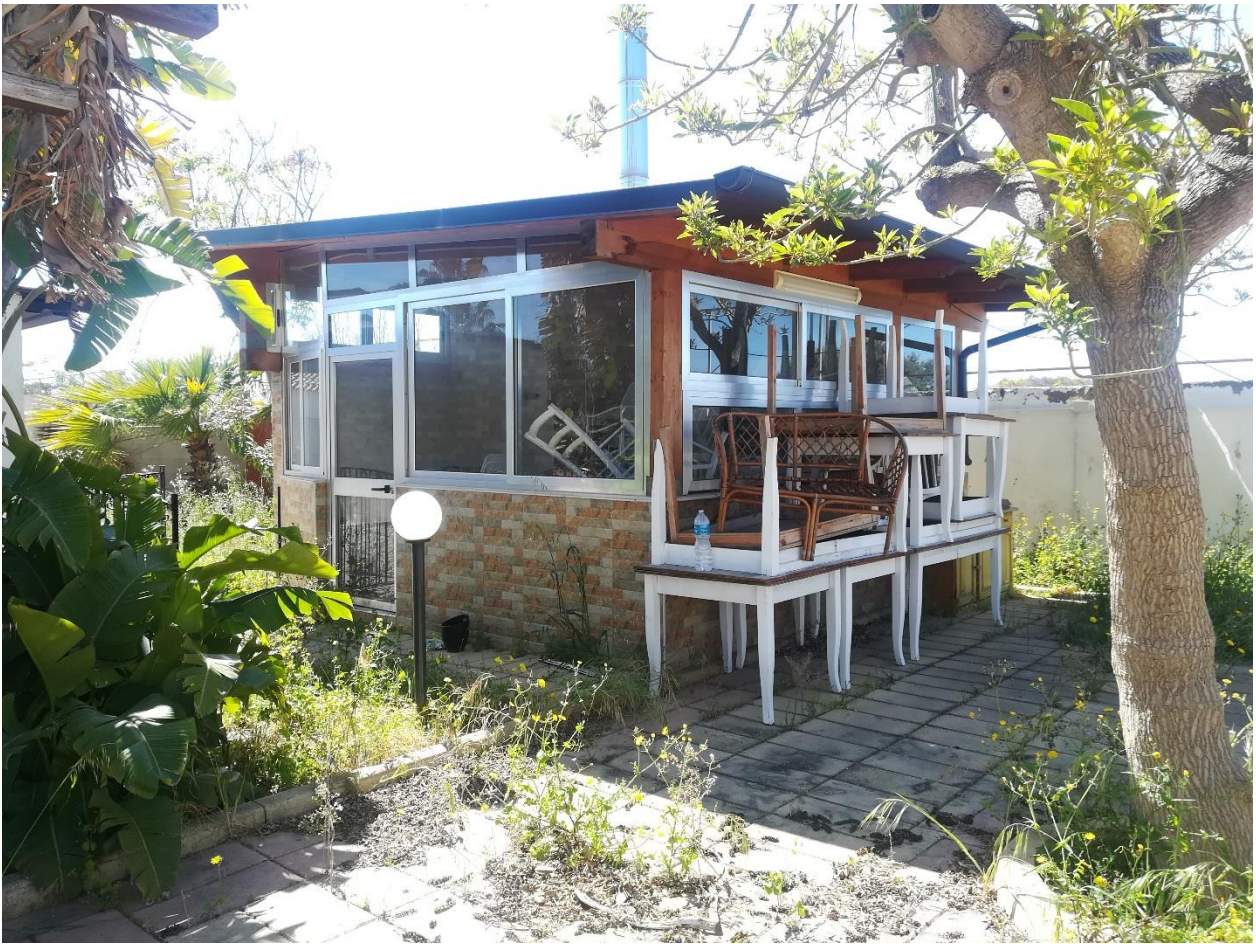
23. Corpo di fabbrica realizzato abusivamente
