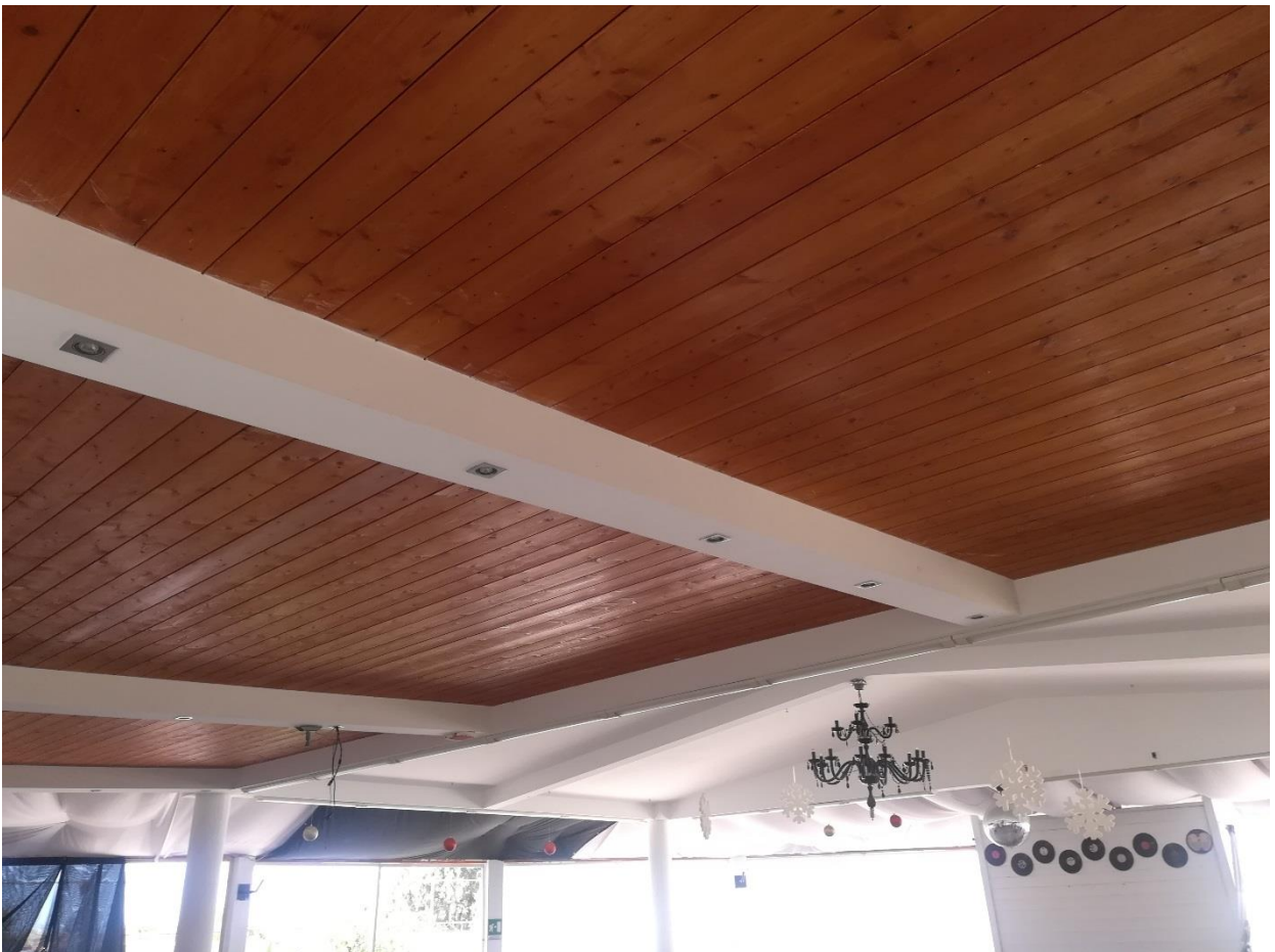
28. Copertura della pista da ballo
