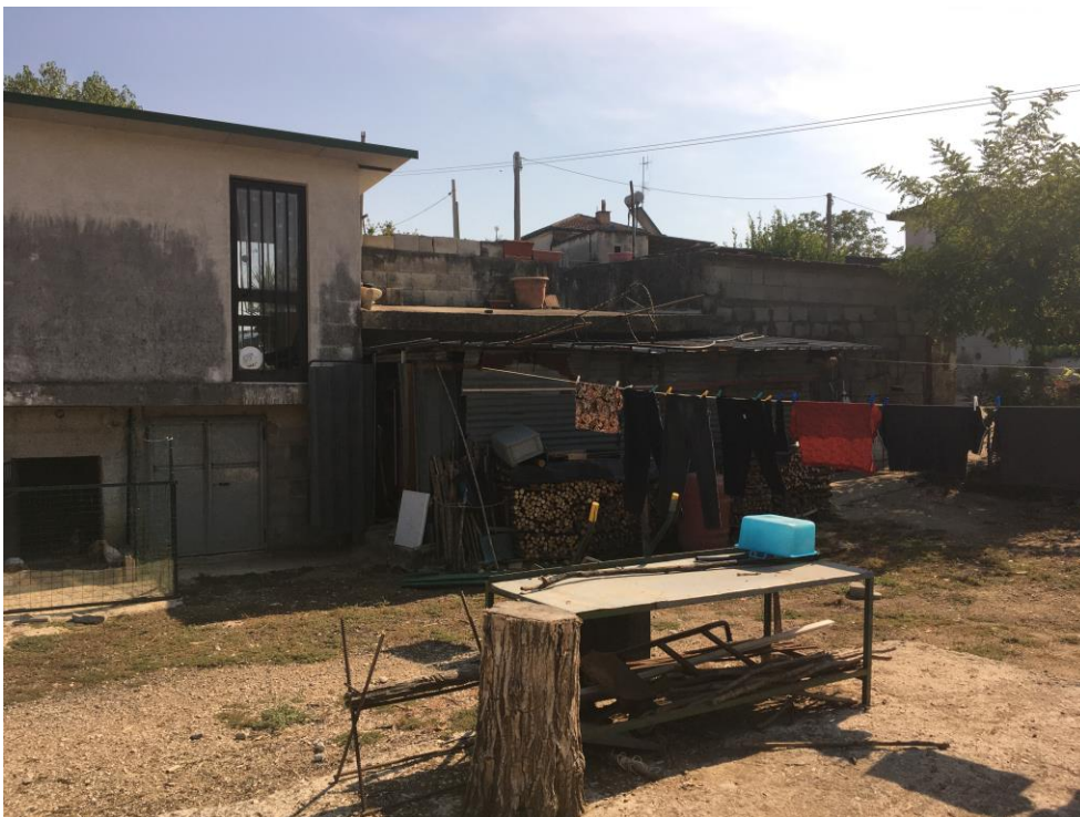
Foto 14. Retro Manufatto abusivo.
