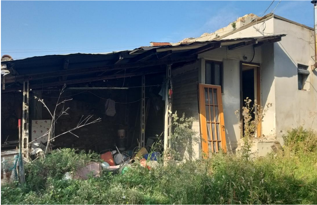
FOTO 13 – Vista fabbricato rurale/tettoia p.lla 473
