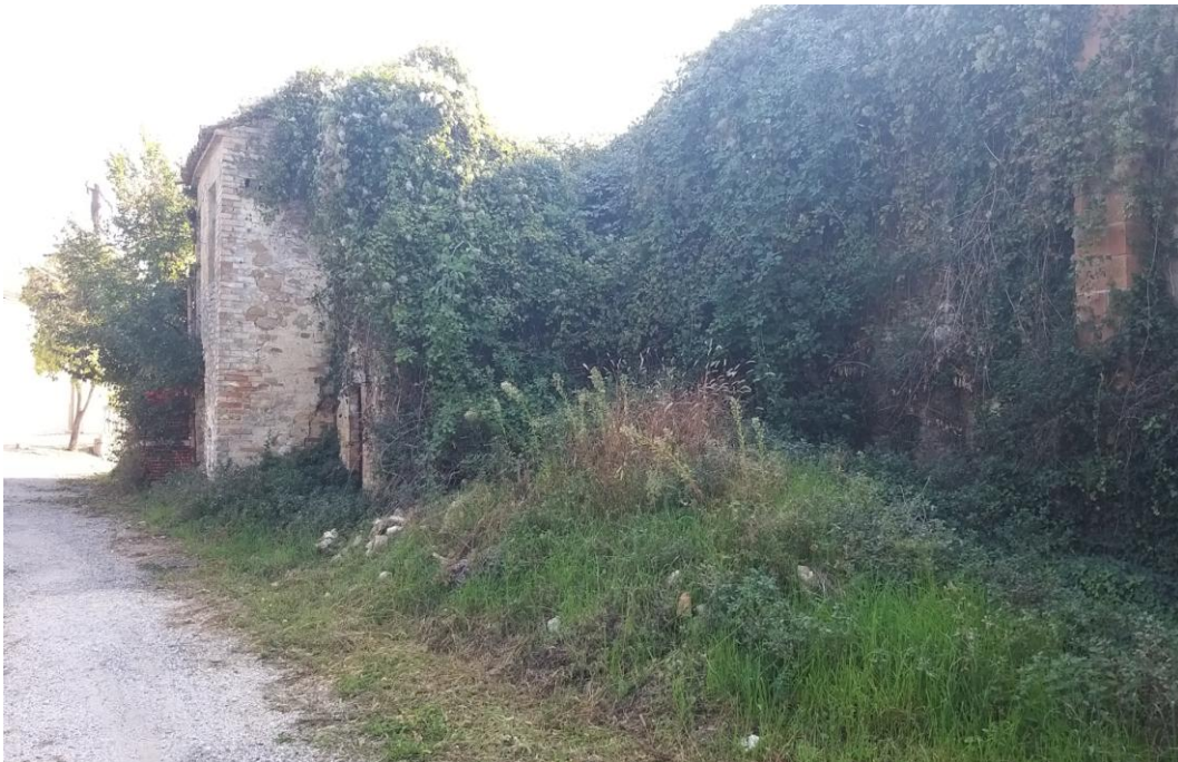
FOTO 2 – Vista lato nord fabbricato rurale p.lla 470 - Diruto
