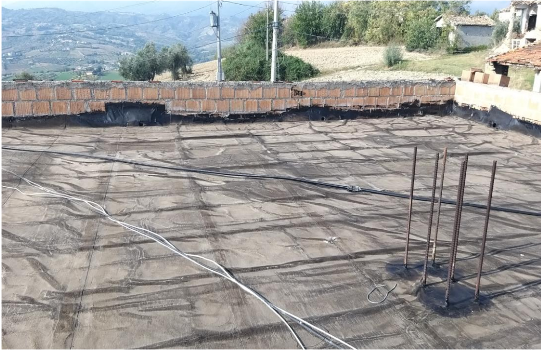
FOTO 50 – Vista terrazzo copertura.
