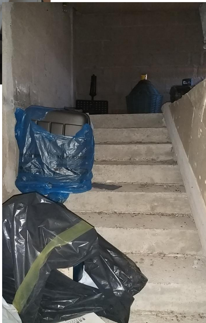
FOTO 47 – Vista vano scala accesso terrazzo copertura.
