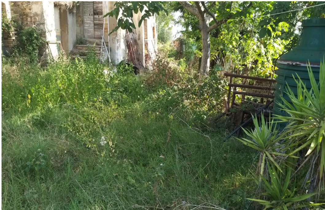
FOTO 6 – Vista area fabbricato rurale p.lla 474 - Demolito
