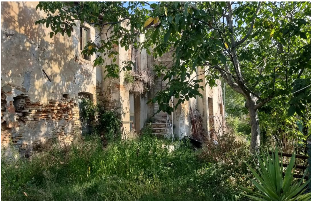
FOTO 4 – Vista lato est fabbricato rurale p.la 470 - Diruto
