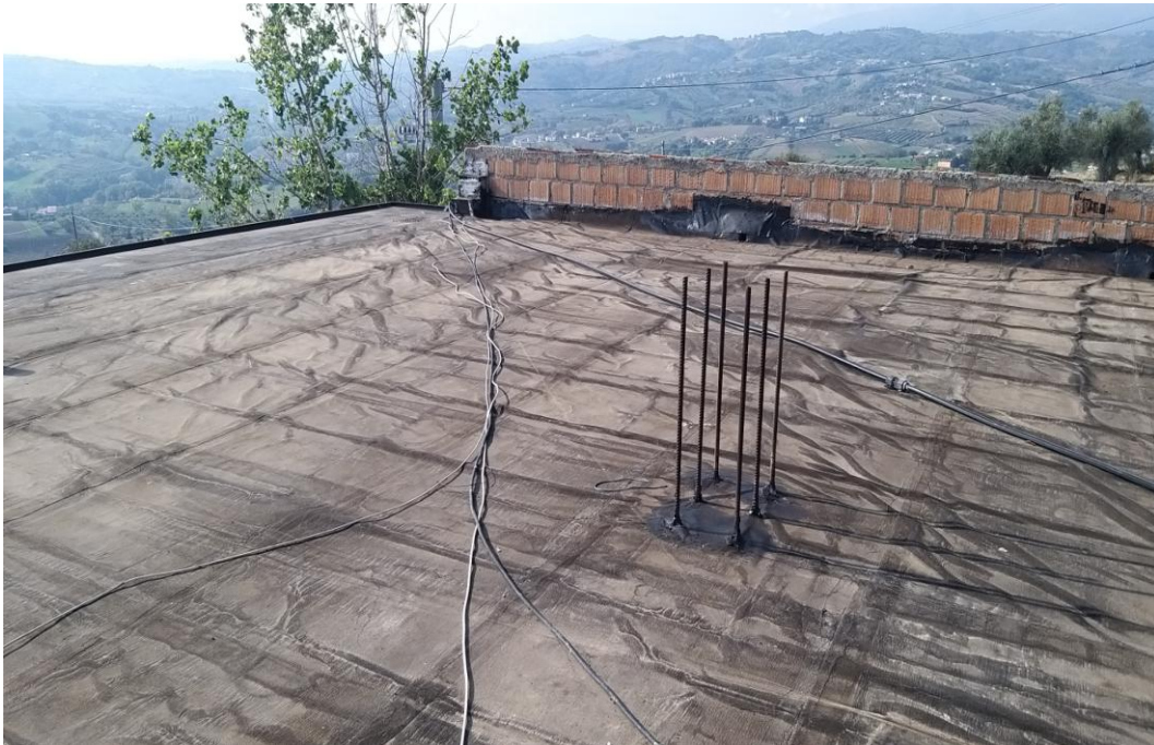
FOTO 51 – Vista terrazzo copertura.
