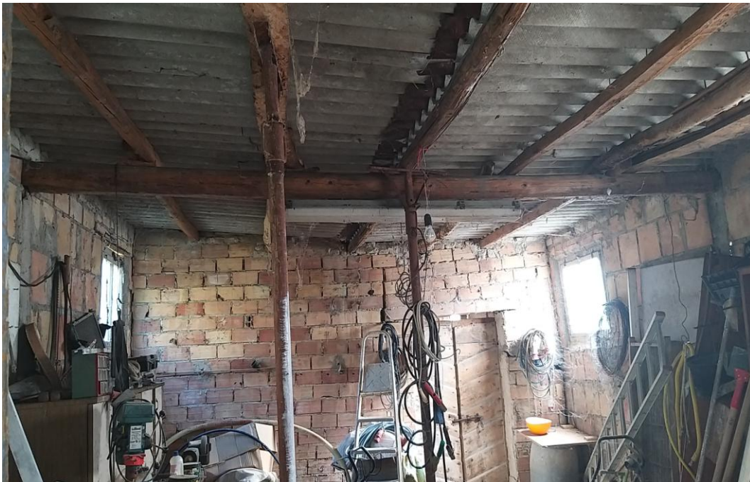
FOTO 53 – Vista interna magazzino/pollaio edificato sulla p.lla 776.
