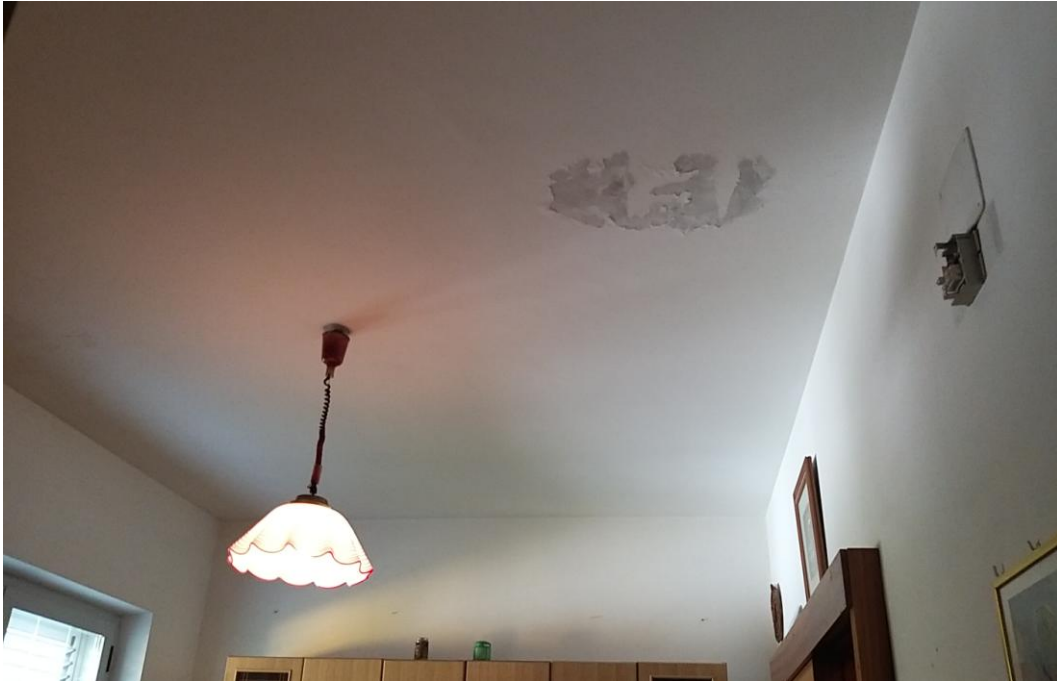
FOTO 38 – Vista zona giorno Appartamento P.1° - Segni infiltrazioni d'acqua.
