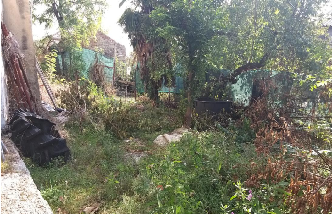
FOTO 7 – Vista area fabbricato rurale p.lla 474 - Demolito
