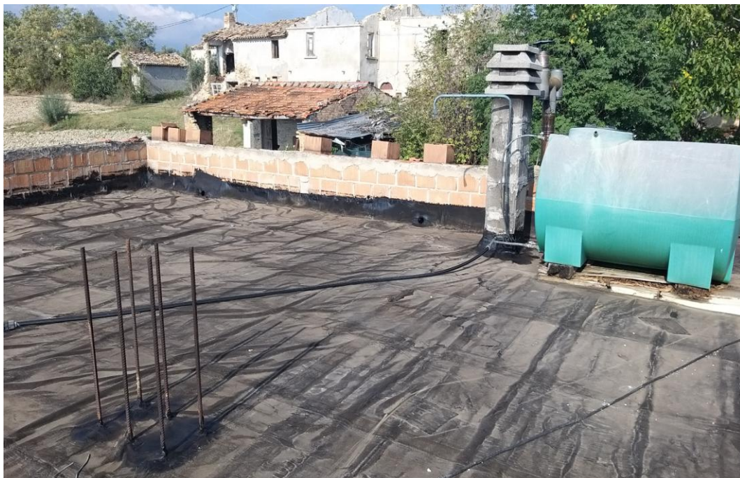
FOTO 49 – Vista terrazzo copertura.
