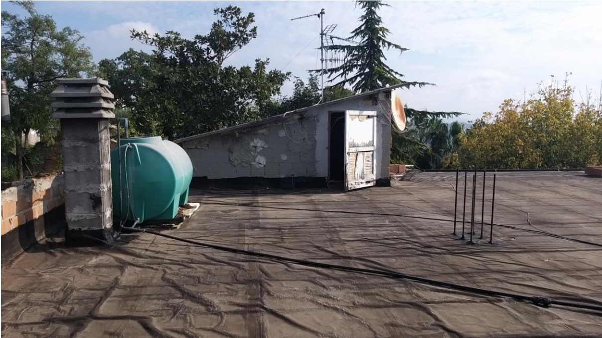
FOTO 48 – Vista terrazzo copertura.
