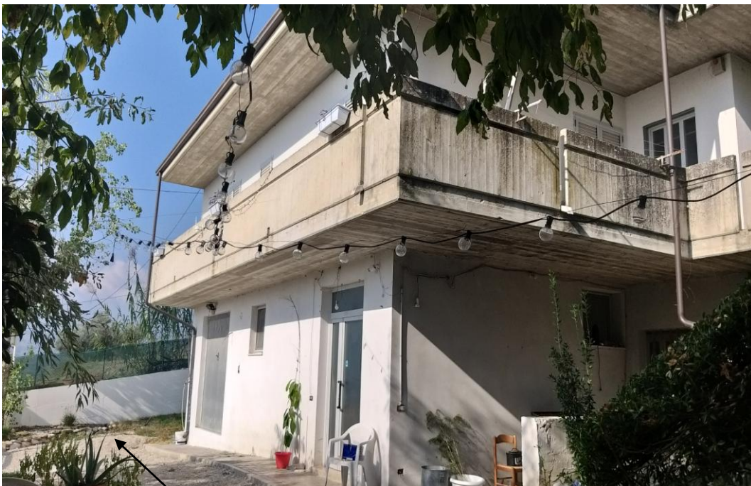
FOTO 10 – Vista terreno p.lla 701
