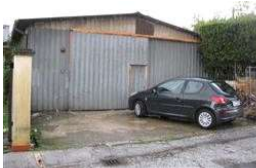
foto del magazzino di cui al Corpo C
