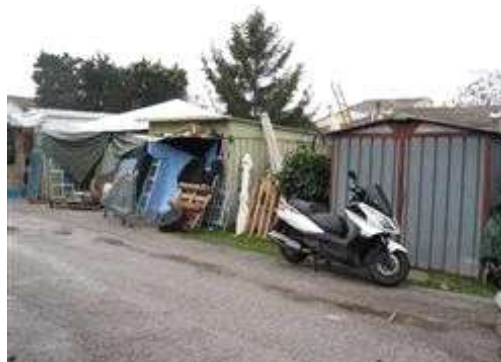
foto dei manufatti presenti sul terreno di cui al Corpo D
