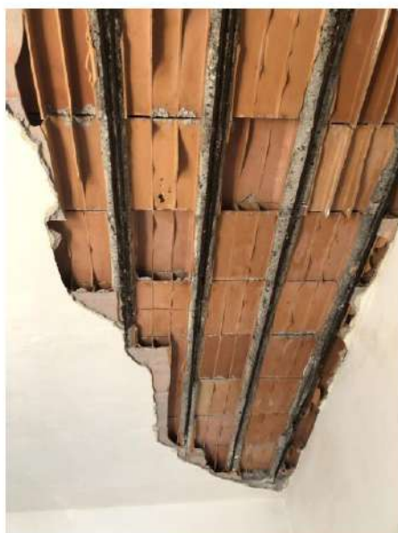
Soffitto Vano 1 (soggiorno) – P3
