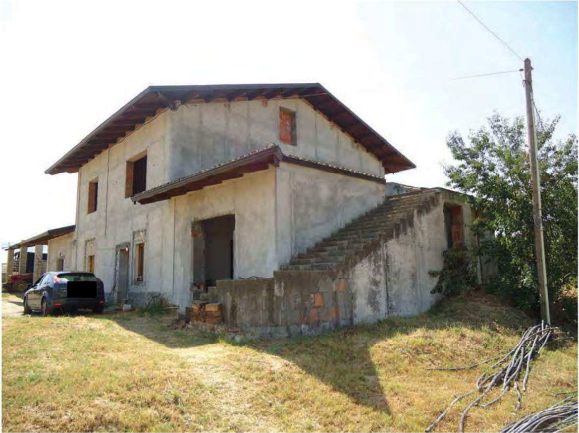
Fabbricato oggetto della perizia – Vista lato Ovest
