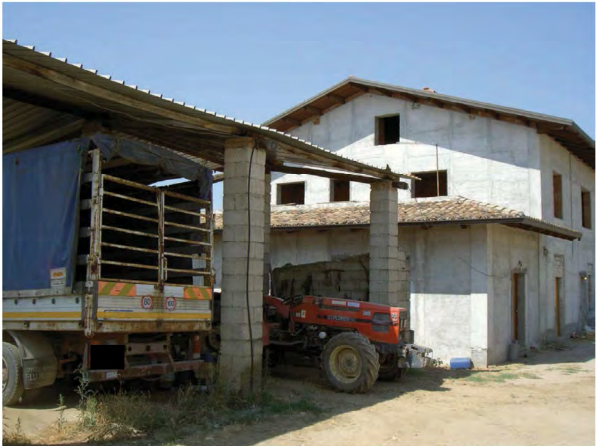
Tettoia oggetto della perizia Foglio 68 pt 205 sub 2 – Vista lato Est.
