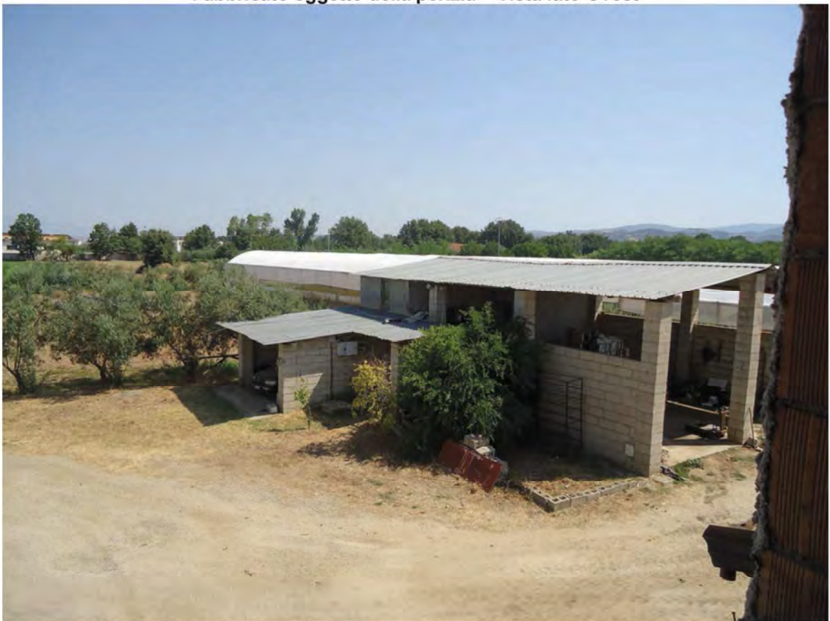
Fabbricato oggetto della perizia Foglio 68 pt 205 sub 3 – Vista lato Ovest
