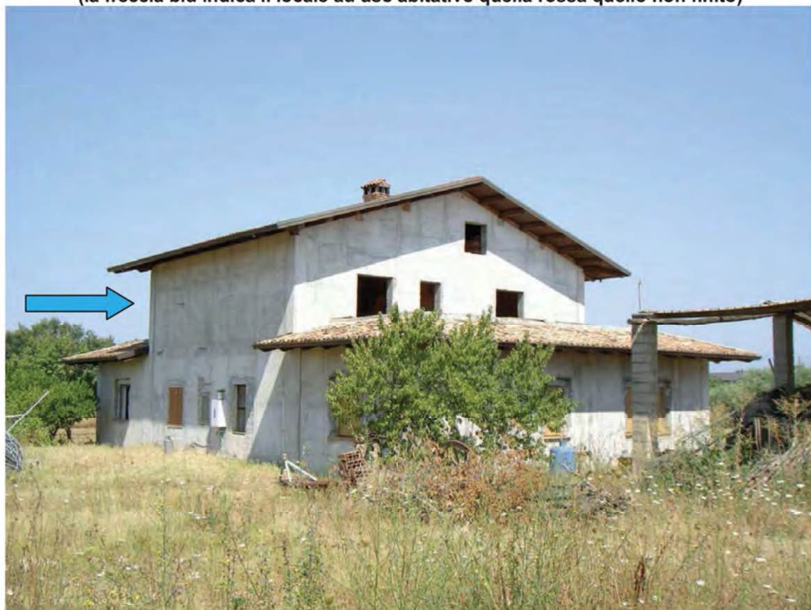
Fabbricato oggetto della perizia – Vista dal retro (in blu la porzione di fabbricato non finito)
