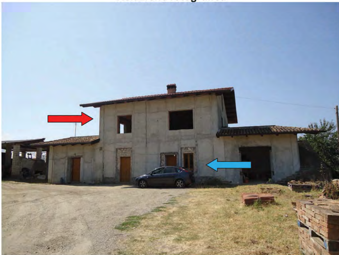
Fabbricato oggetto della perizia Foglio 68 pt 205 sub1 – Vista da Contrada Succiommo (la freccia blu indica il locale ad uso abitativo quella rossa quello non finito)
