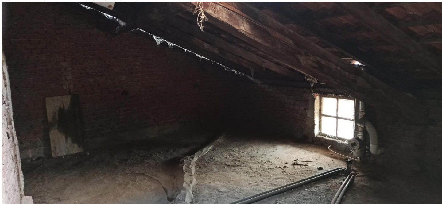
SUB 25 LOCALE DEPOSITO SOTTOTETTO
