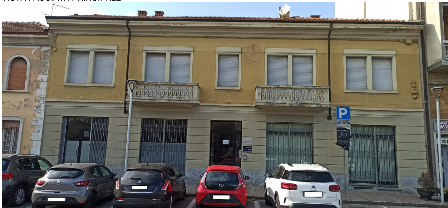
VISTA FACCIATA PRINCIPALE
