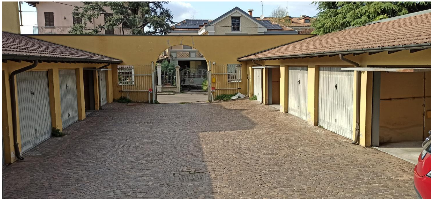
VISTA FACCIATA BOX E MAGAZZINI
