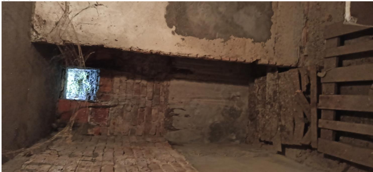
SUB 25 LOCALE DEPOSITO SOTTOTETTO
