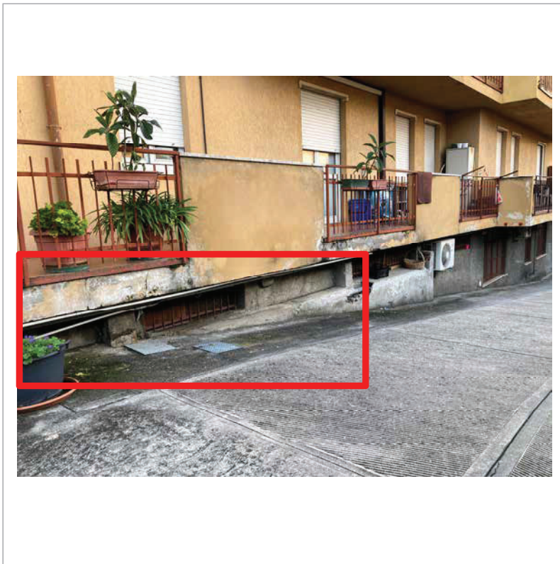
Veduta dell'immobile dalla rampa di accesso
