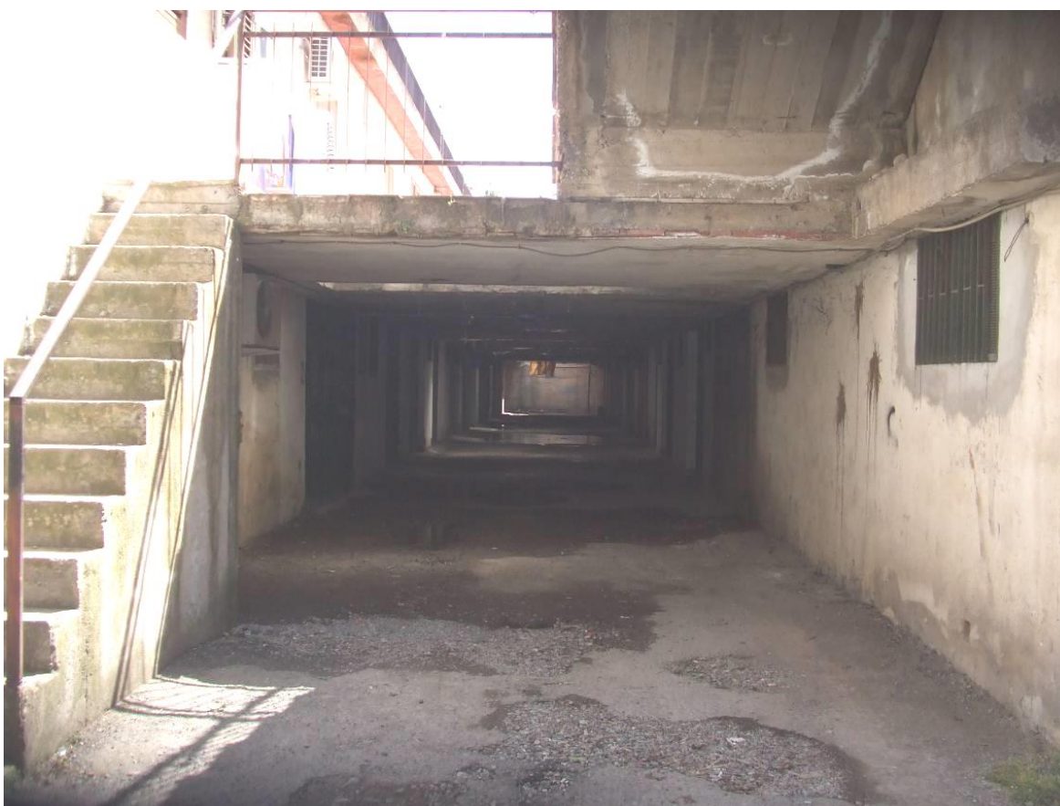
Vista esterna (tunnel d'ingresso)
