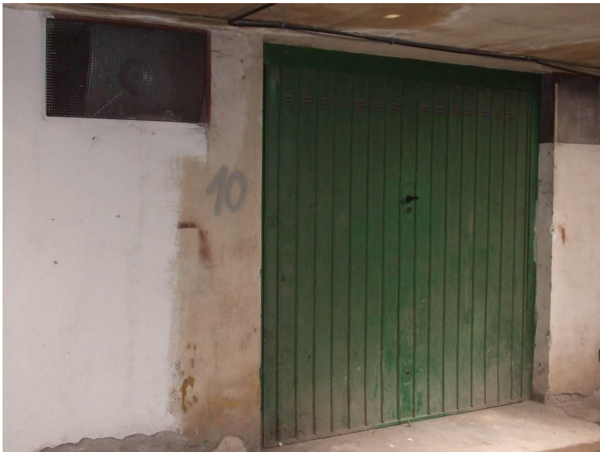
Foto n. 01: Vista esterna della basculante d'ingresso
