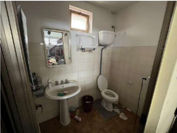
Bagni/Servizi igienici del Capannone/Opificio principale (A)
