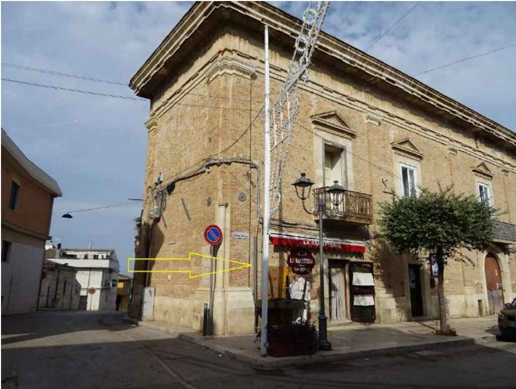
Foto n. 1 Foto Prospetto C.so Vittorio Veneto n. 8
