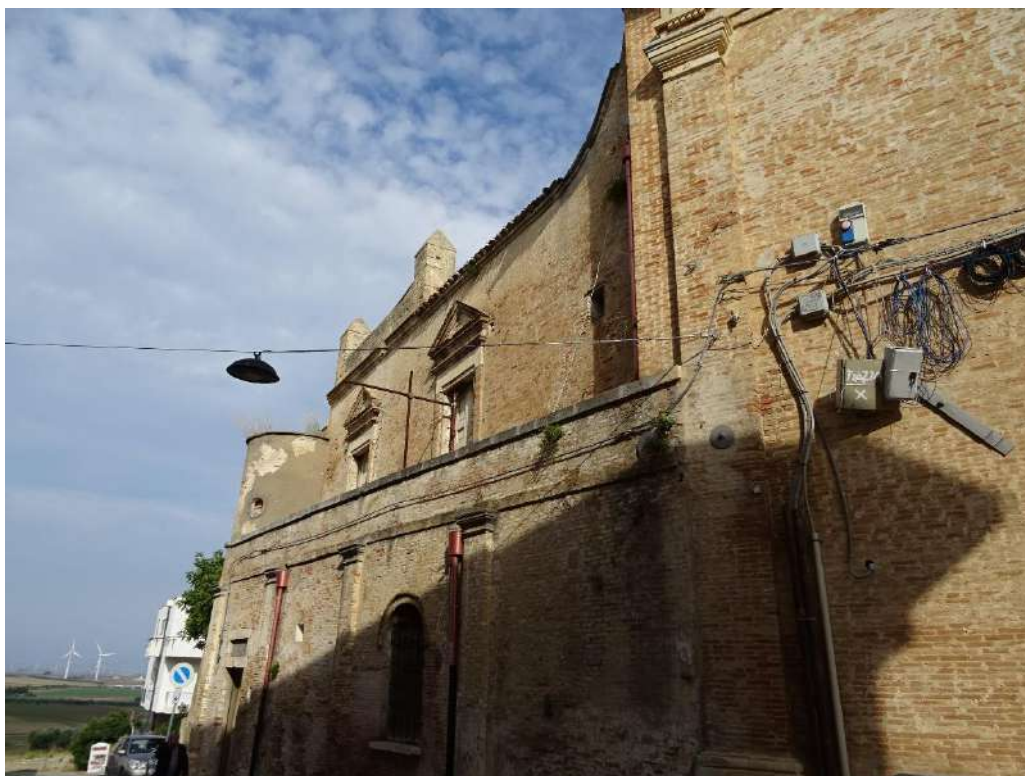
Foto n. 2 Prospetto Via Duca D'Aosta
