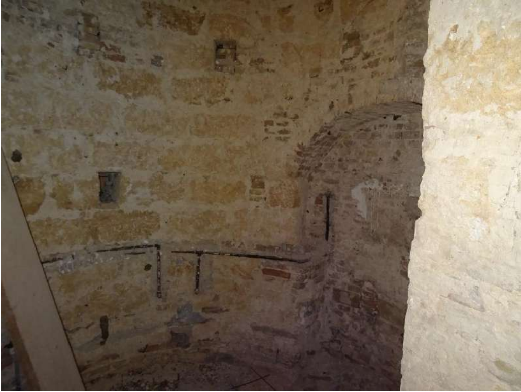
Foto n. 13 Bagno presente all'interno della 1° stanza
