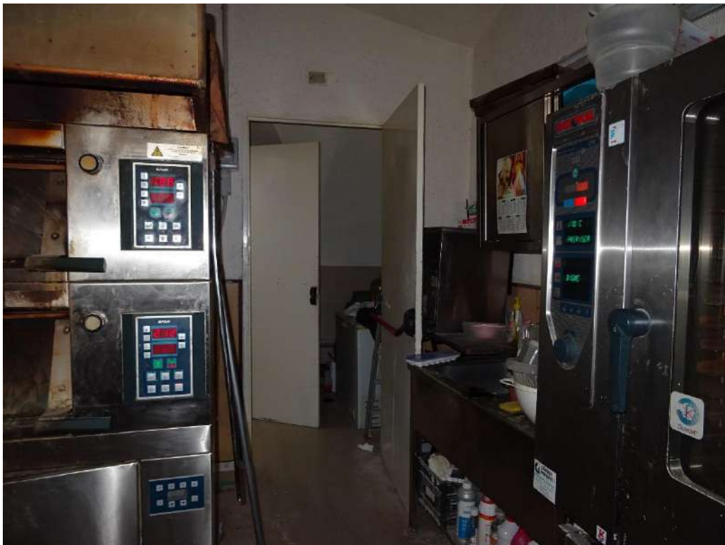
Foto n. 8 Interno zona laboratorio
