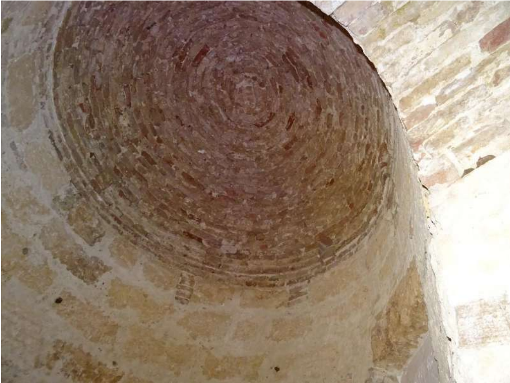
Foto n. 15 Copertura bagno presente 1° stanza
