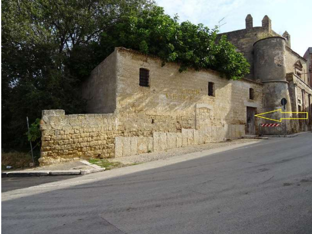
Foto n. 13 Foto ingresso Via Duca D'Aosta n.3
