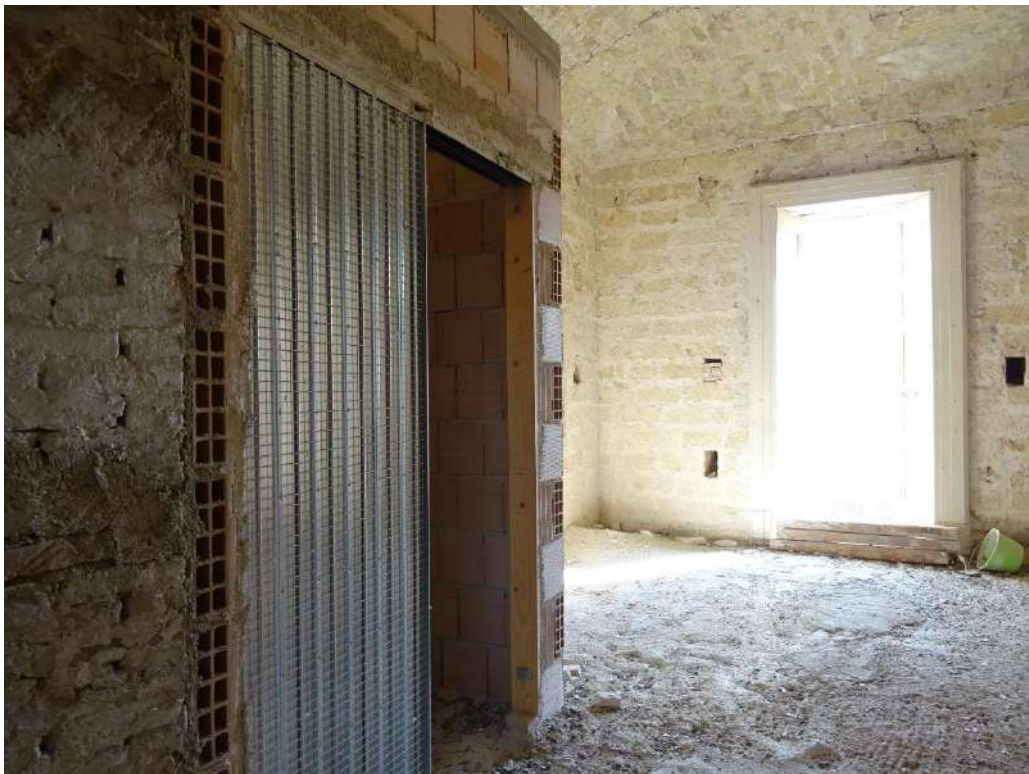
Foto n. 18 Stanza camera da letto verso ripostiglio
