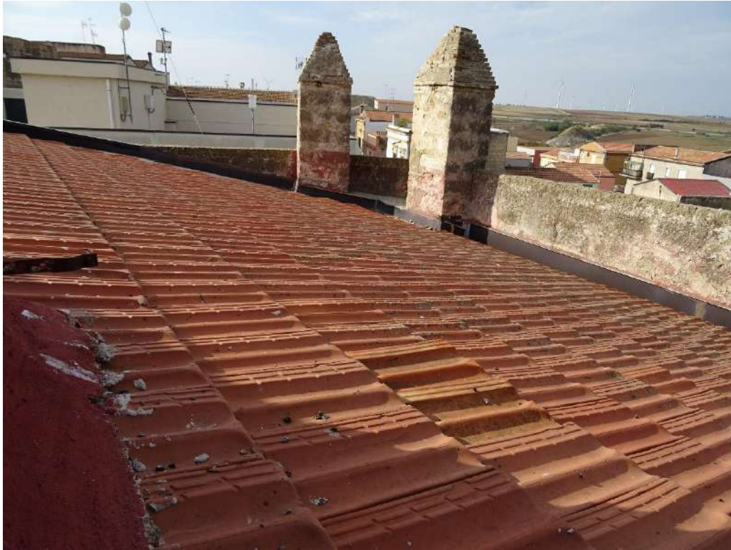
Foto n. 29 Copertura a falda inclinata con tegole marsigliesi
