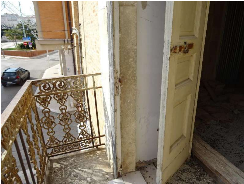
Foto n. 20 Particolare balcone prospiciente C.so Vittorio Veneto
