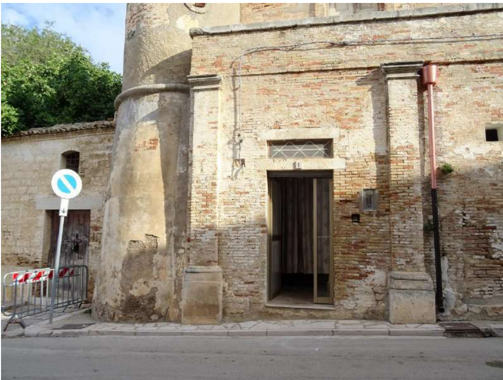
Foto n. 2 Foto ingresso Via Duca D'Aosta n. 1
