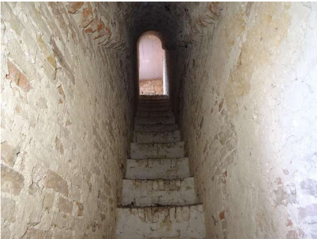
Foto n. 26 Scala di accesso al tetto
