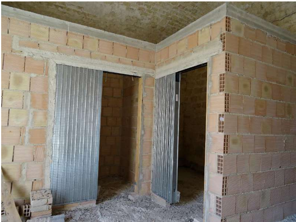
Foto n. 22 Interno camera da letto verso bagno e ripostiglio
