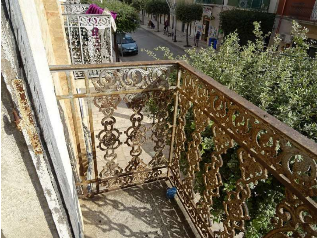
Foto n. 21 Particolare balcone prospiciente C.so Vittorio Veneto
