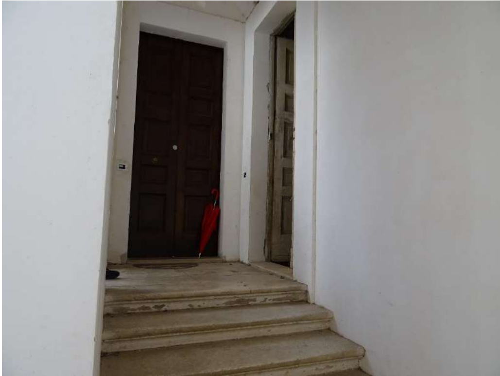
Foto n. 7 Pianerottolo di arrivo
