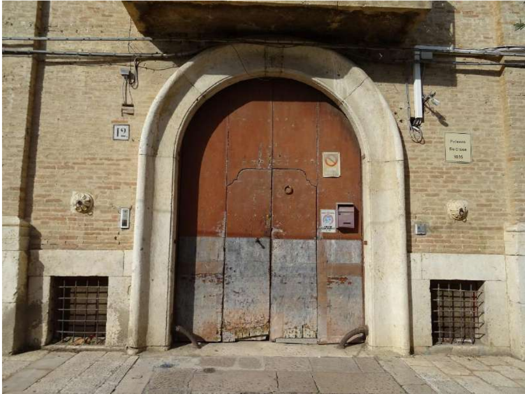
Foto n. 3 Portone di ingresso - C.so Vittorio Veneto n. 12
