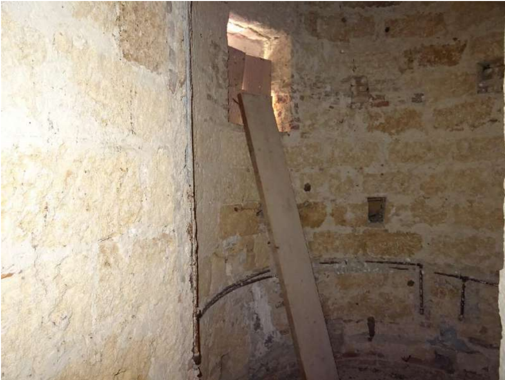
Foto n. 14 Bagno presente all'interno della 1° stanza
