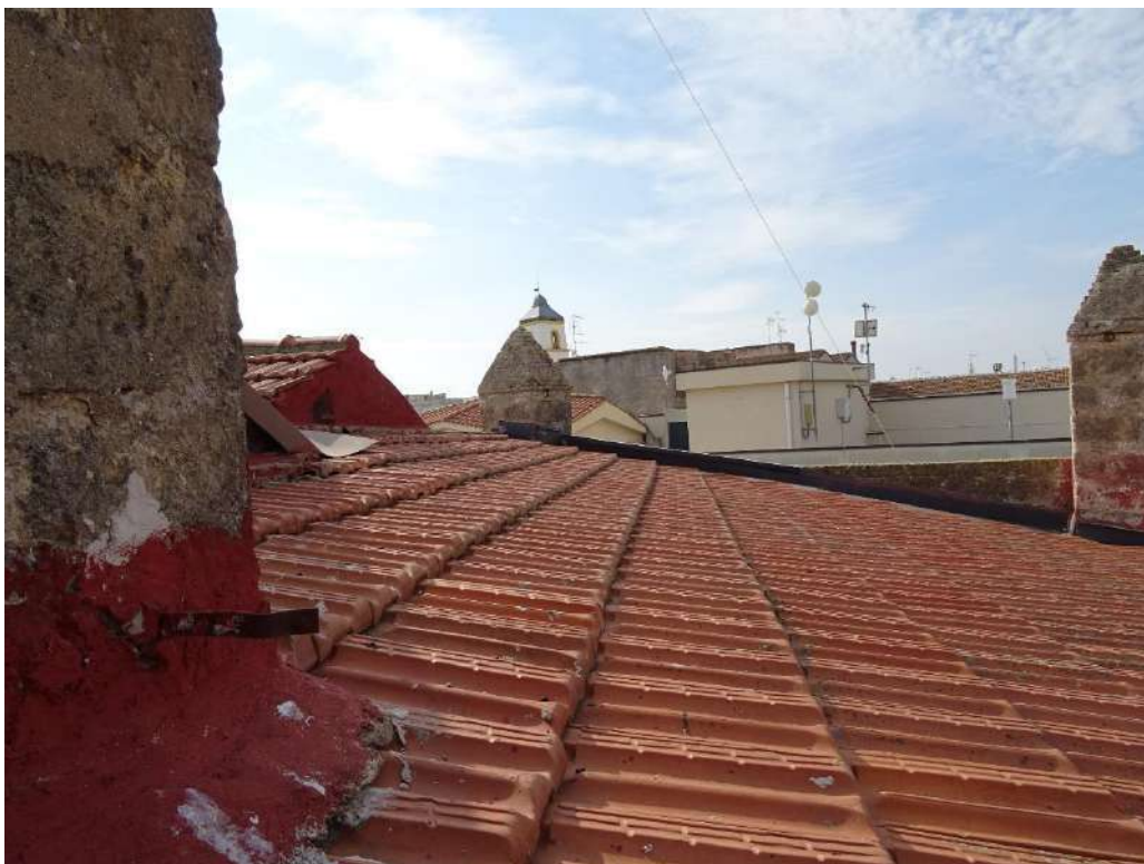
Foto n. 30 Copertura a falda inclinata con tegole marsigliesi
