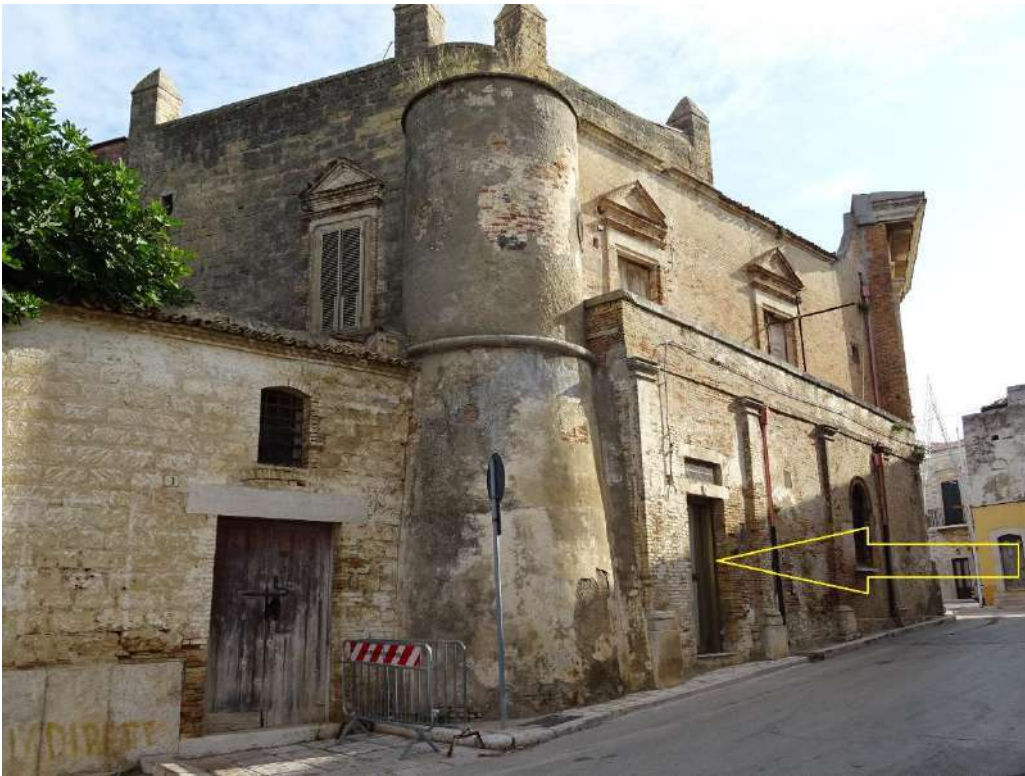
Foto n. 1 Foto Prospetto Via Duca D'Aosta n. 1
