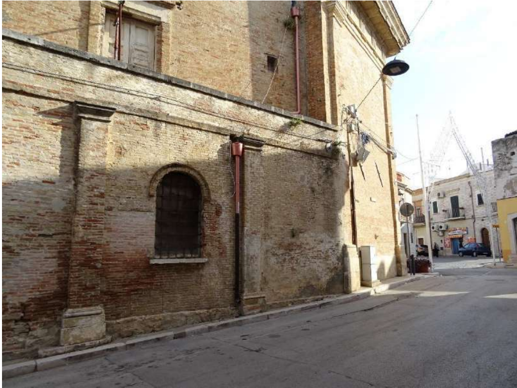
Foto n. 3 Prospetto su via Duca D'Aosta
