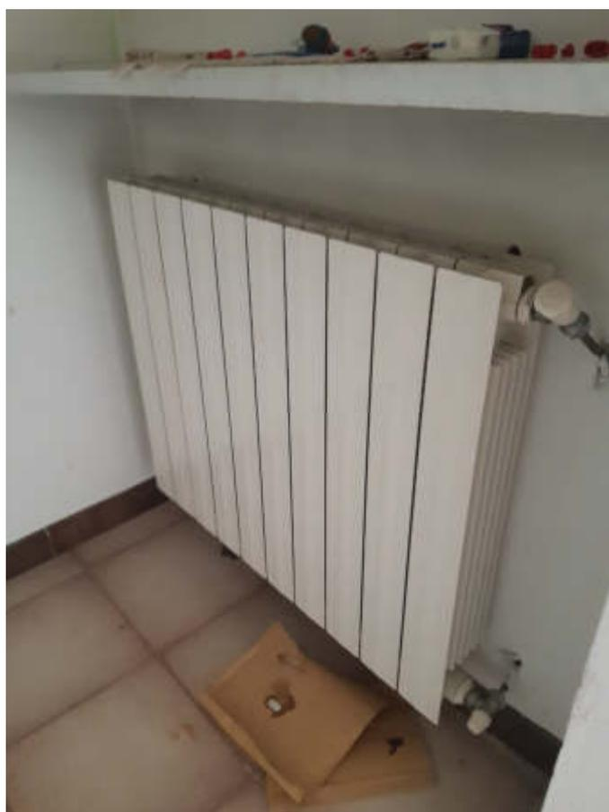
Vista generatore impianto riscaldamento e tipologia batterie termosifoni a servizio dei vani di abitazione
